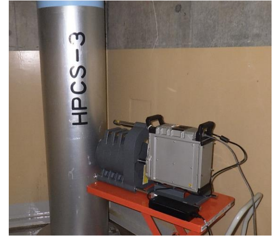
可搬型ゲルマ測定器による 配管付着放射能測定 (測定箇所：約20ポイント)
