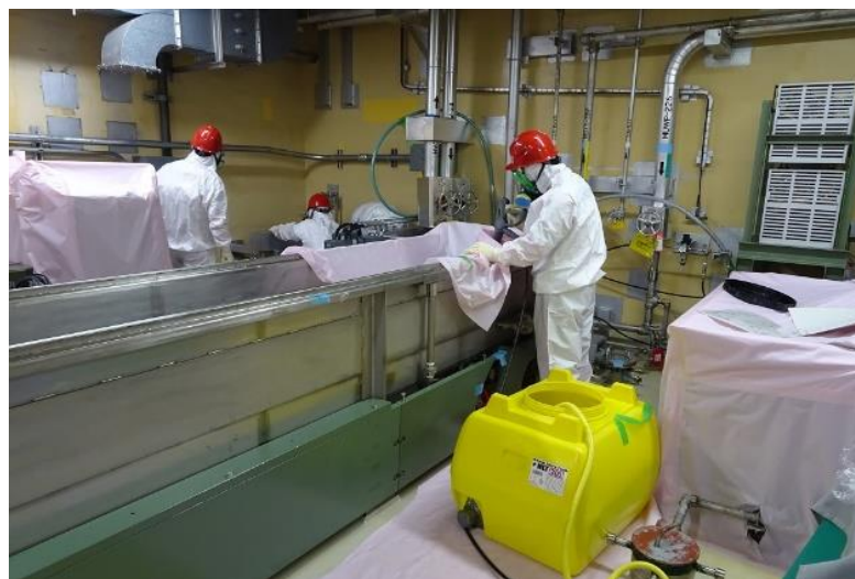
3号炉除染作業
