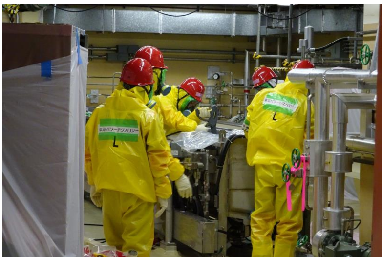
1号炉除染作業
