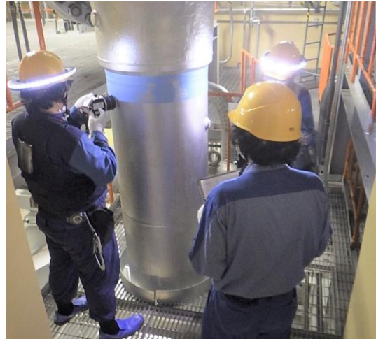
電離箱式サーベイメータによる 配管の表面線量当量率測定 (測定箇所：約1400ポイント)
