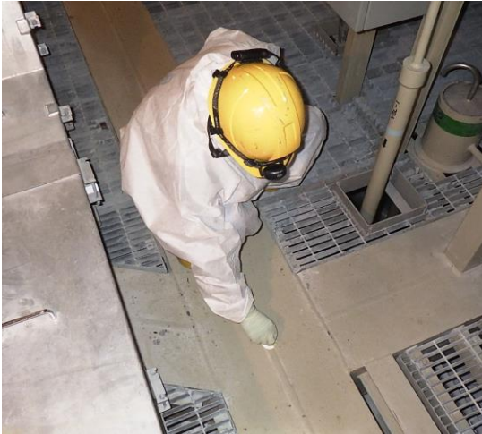
スミア測定※3による 建屋表面汚染密度測定 (測定箇所：約200ポイント)
