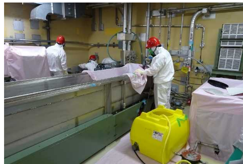
3号炉 除染作業
