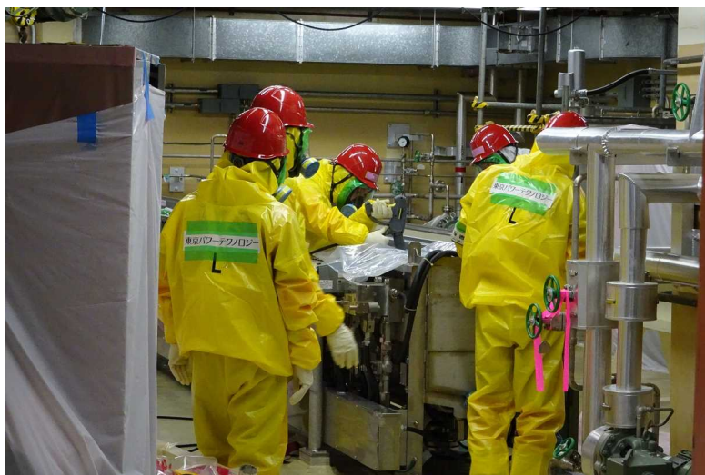
1号炉 除染作業
