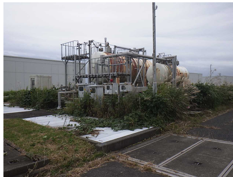
2号炉薬液タンク（解体前）
