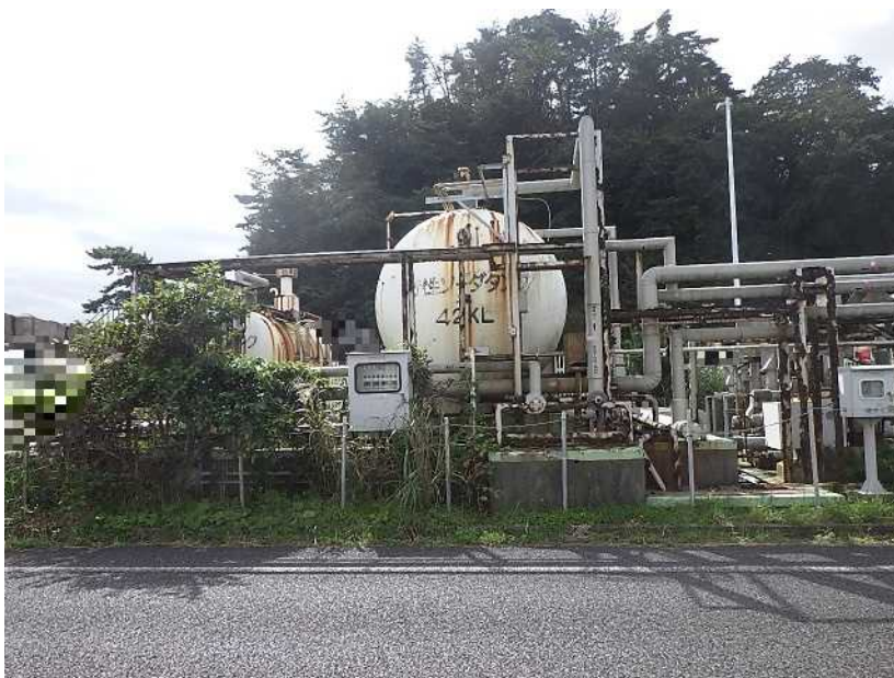
1号炉薬液タンク（解体前）
