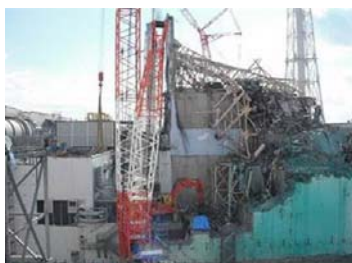
【大型がれき撤去前】
