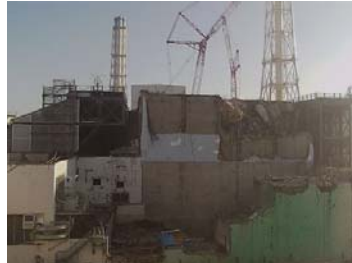
【大型がれき撤去後】
