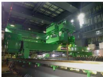
【天井クレーン・燃料取扱機】
