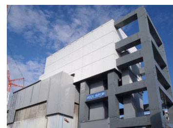
【外観(燃料取出し用カバー)】
