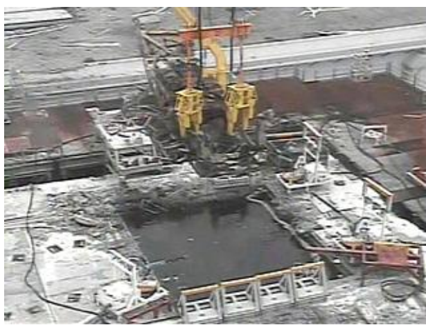
3号機の燃料交換機撤去
