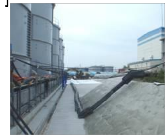
浸透防止施工後
