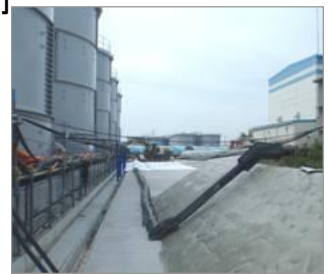
浸透防止施工後
