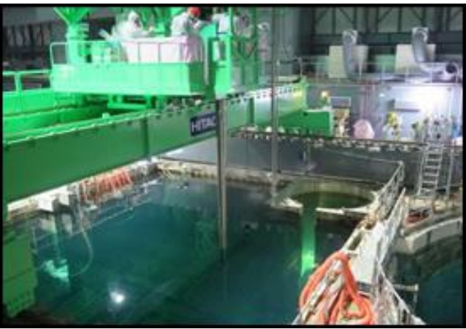
4号機からの燃料取り出し
