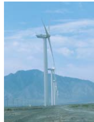
新疆ウイグル地区・ウラボ風力発電所
