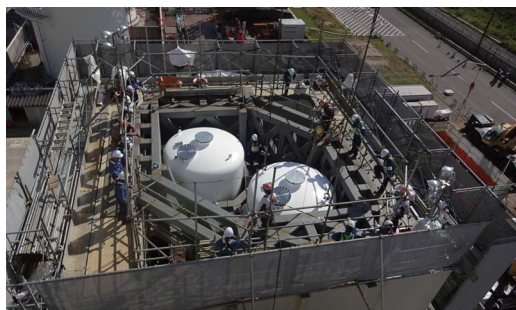
柏崎刈羽原子力発電所7号機の地上式フィルタベント設備のヨウ素フィルタ据え付け工事
