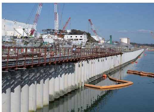
2015年10月に閉合作業が完了した海側遮水壁
