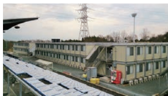
作業拠点として利用時のスタジアム
