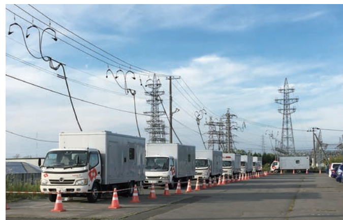
北海道の被災エリアに派遣された高圧発電機車(2018年9月)
