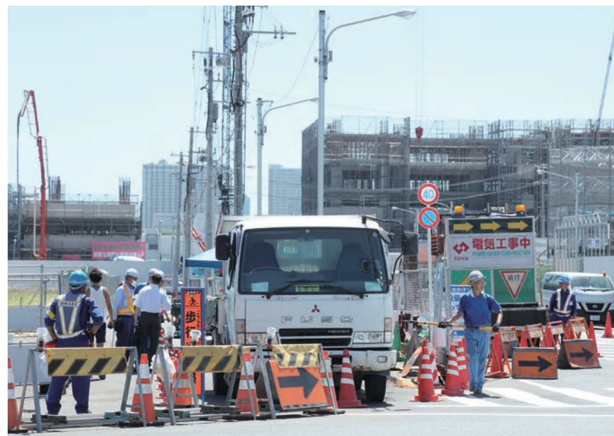
建設が進む選手村工事現場(東京都江東区)
