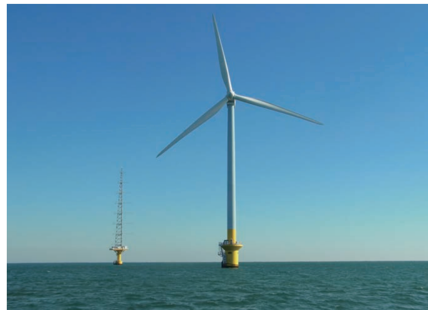
銚子沖洋上風力発電実証研究設備 (千葉県)
