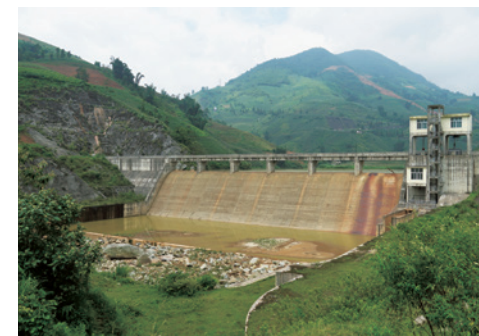
コクサン水力発電所ダム
