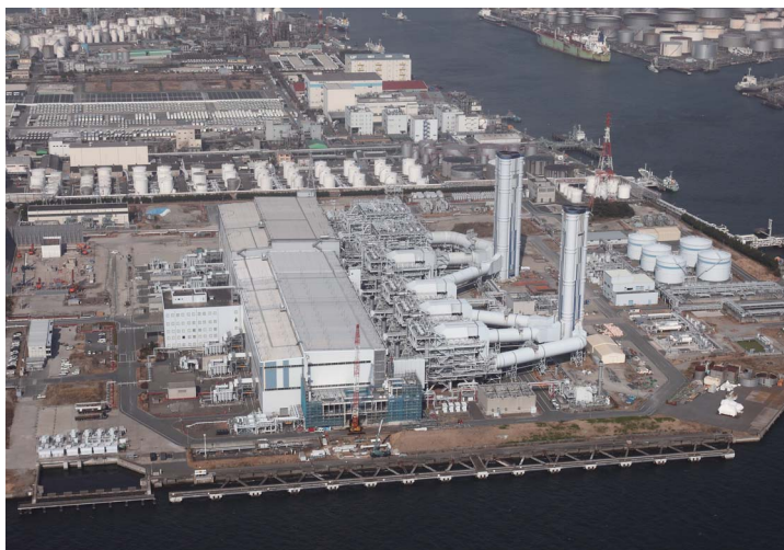
MACC II (More Advanced Combined Cycle II)を導入し営業運転を開始した川崎火力発電所2号系列第2軸
