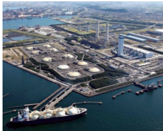
富津火力発電所全景
