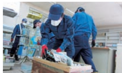
店舗の清掃・片付け作業。復興推進活動への参加実績は累計約146,000人・日
