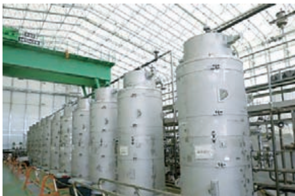
高性能多核種除去設備（吸着塔）
