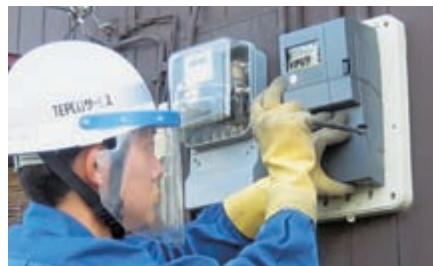
スマートメーターの設置作業
