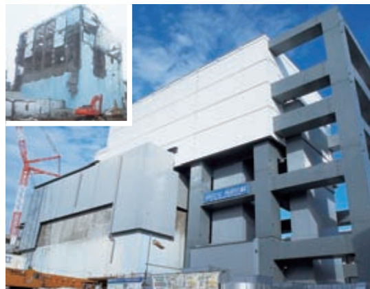
燃料取り出し用カバーを設置した4号機原子炉建屋 （左上は事故直後の平成23年3月に撮影した4号機原子炉建屋）
