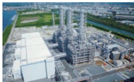
コンバインドサイクル化した千葉火力発電所3号系列
