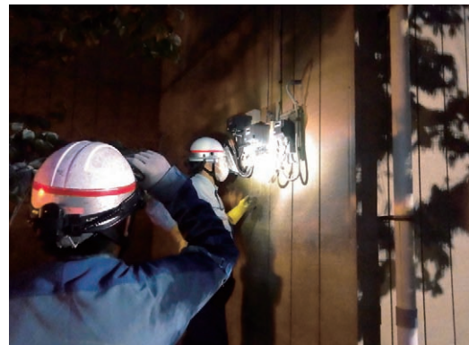
夜間の健全性確認作業
