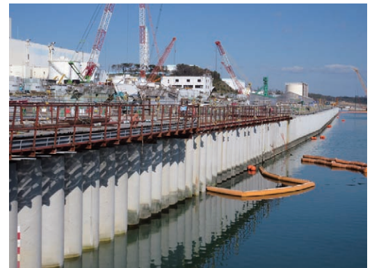
閉合作業完了後の海側遮水壁 鋼管矢板594本を使用し、全長約780mの壁を建設しました。
