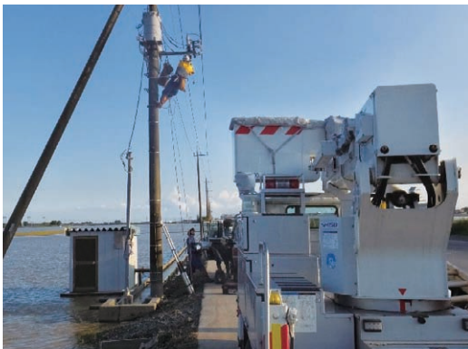
浸水地域での復旧作業
