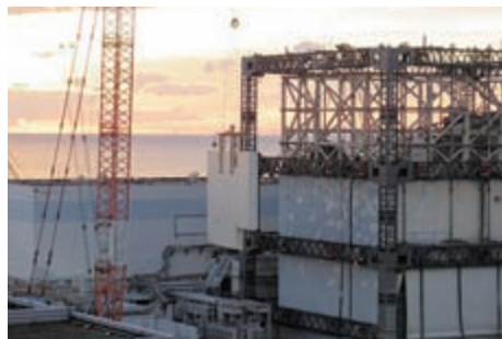
昨年11月に壁パネルの取り外し作業が完了した1号機原子炉建屋
