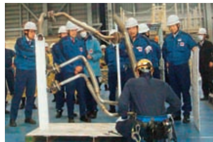
秒単位での作業手順の分析などにより配管フランジ結合作業の所要時間を大幅に短縮
