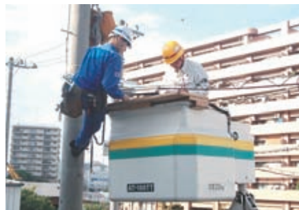
多能化により通信と配電の工事を同時に実施することで通信ケーブル工事を効率化
