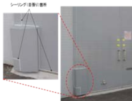
外部扉の防水化
