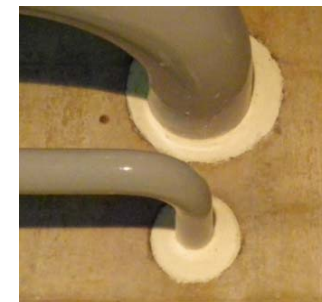
建屋貫通口の防水化
