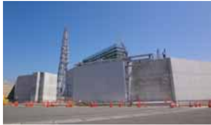
1~4号機側（荒浜側）6月25日現在
