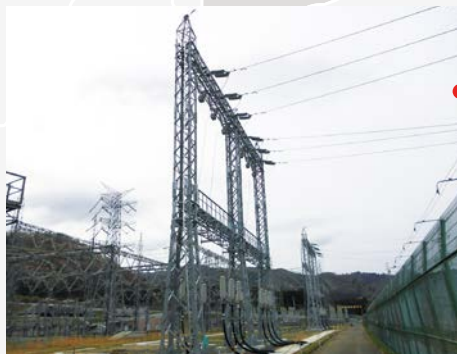
新福島変電所
