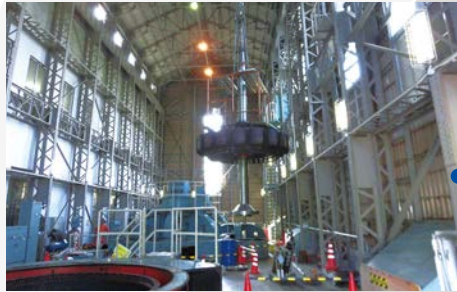
日橋川発電所
