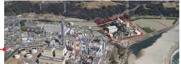
勿来IGCCパワー合同会社 *赤枠内:イメージ図 (三菱商事パワー株式会社、三菱重工株式会社、三菱電機株式会社、東京電力ホールディングス株式会社、常磐共同火力株式会社の5社が出資)
