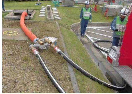
[淡水貯水池を水源とした場合] 送水ホースと可搬型代替注水ポンプ 吸管との接続
