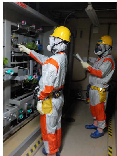
減圧確認(現場)
