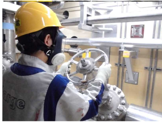
復水移送ポンプ吸込ライン切替え
