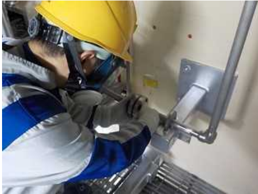
仮設ホース接続
