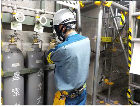
窒素ガスポンベ交換
