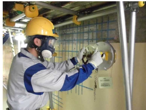
現場での注水操作
