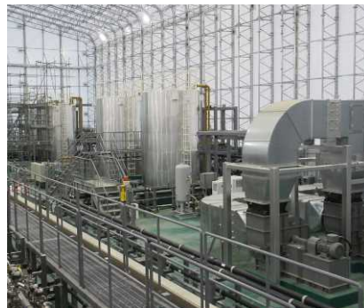
処理水タンク・供給タンクエリア
