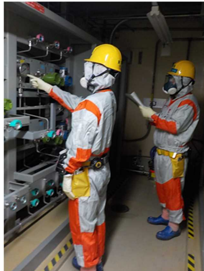
減圧確認(現場)
