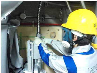
リンク機構の取外し操作
