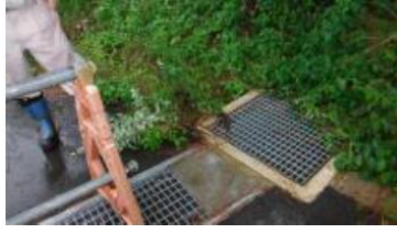
⑥-16 グレーチング
