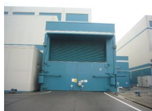
①-13 シャッター (大物搬入口)
