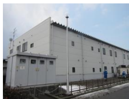
④-1 屋根, 外壁
