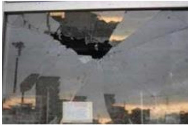
ガラスへの飛来物の衝突痕
