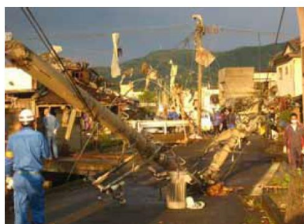
(電柱の折損、傾斜)
