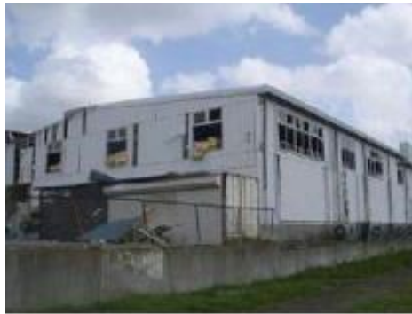
窓ガラスの破損
