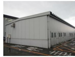
④-24 屋根, 外壁
