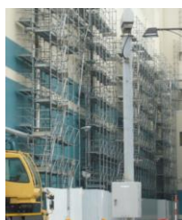
①-2 仮設足場
