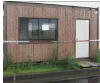
①-27 仮設小屋
