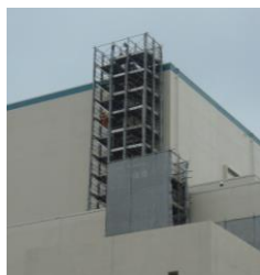
①-1 仮設足場
