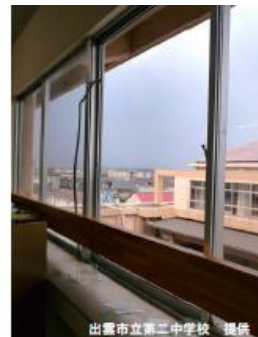
(c) 屋外に面した窓ガラス
