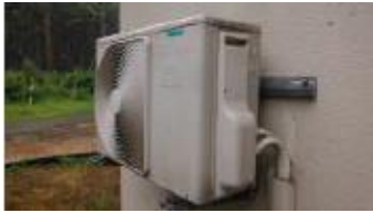
⑥-22 空調室外機
