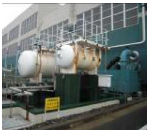
①-31 鋼製タンク
