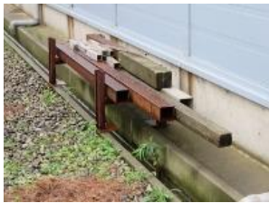
④-52 角型鋼管
