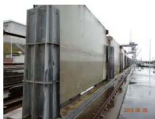
⑦-8 コンクリート板
