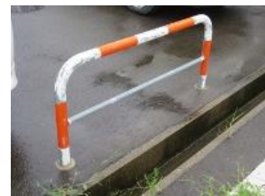
④-57 鋼製フェンス
