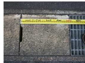
④-3 コンクリート板 (排水溝蓋)
