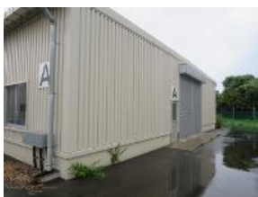
⑤-13 屋根, シャッター
