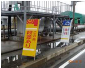
⑦-19 工事看板
