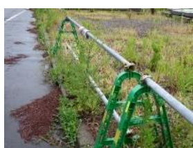
⑤-4 鋼製車止め （単管バリケード）
