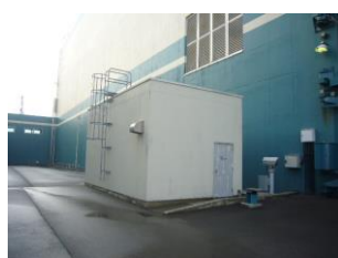
①-20 扉, 換気フード, 猿梯子
