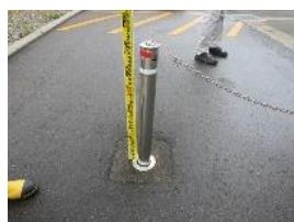
④-13 鋼製車止め
