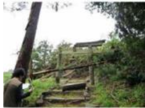
倒木の折損と鳥居の被害
