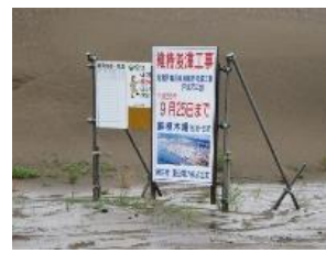
③-33 工事看板
