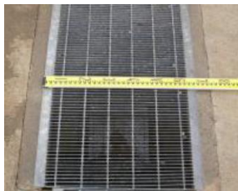
⑦-1 グレーチング
