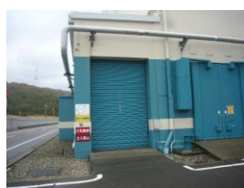
①-23 シャッター, 配管
