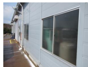
④-12 窓ガラス
