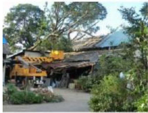
樹木の倒壊による小屋組の被害
