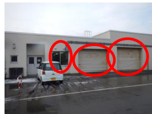
⑤-2 シャッター, 窓ガラス
