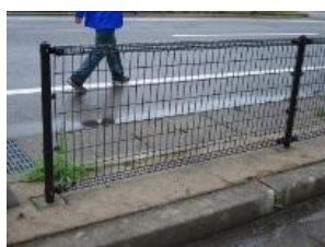
④-40 鋼製フェンス
