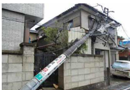
(電柱の折損、傾斜)
