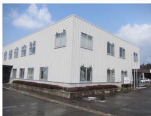
④-11 窓ガラス
