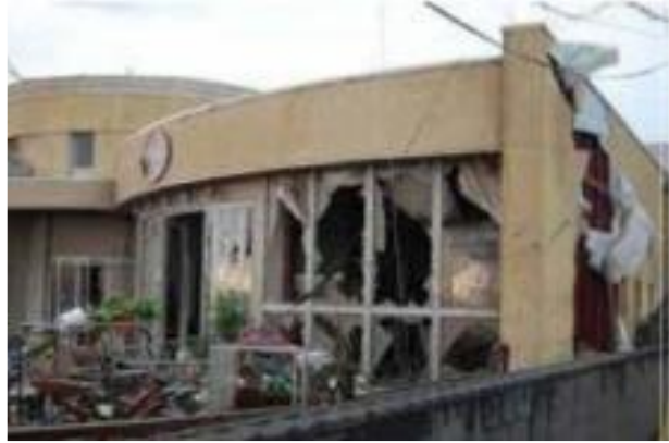
店舗の窓ガラスの被害状況
