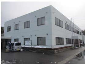
④-2 窓ガラス
