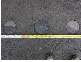
④-16 排水溝蓋
