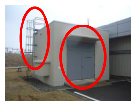
①-9 庇, 猿梯子, 扉
