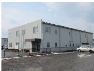
④-10 屋根, 外壁
