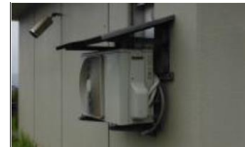
⑥-27 空調室外機
