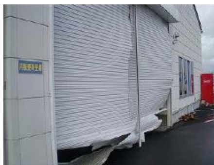
シャッターの破損
