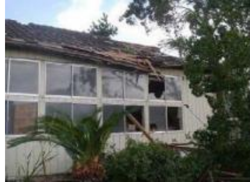
倉庫の窓ガラスと屋根の被害状況
