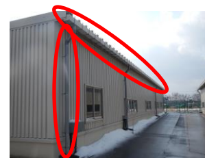
⑤-6 配管, 雨樋
