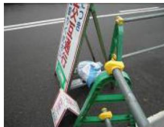
①-32 工事看板
