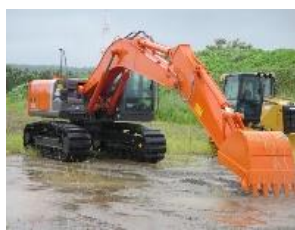
③-32 建設重機 (バックホー)
