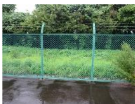
⑤-10 鋼製フェンス
