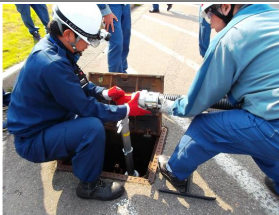
写真4 消火栓接続
