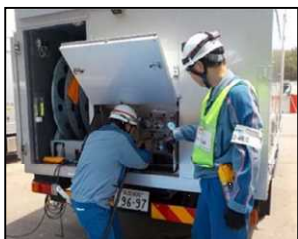
電源車の起動操作訓練
