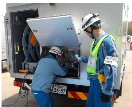
電源車の起動操作訓練
