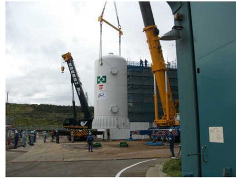
フィルタベント設備の搬入・設置 (柏崎刈羽7号炉)
