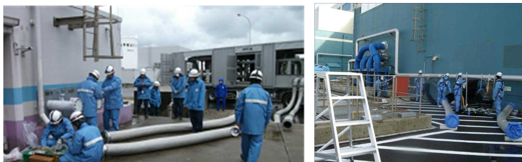
代替原子炉補機冷却系熱交換器ユニット等の接続訓練
