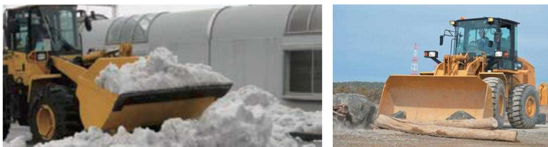
重機による障害物の撤去訓練
