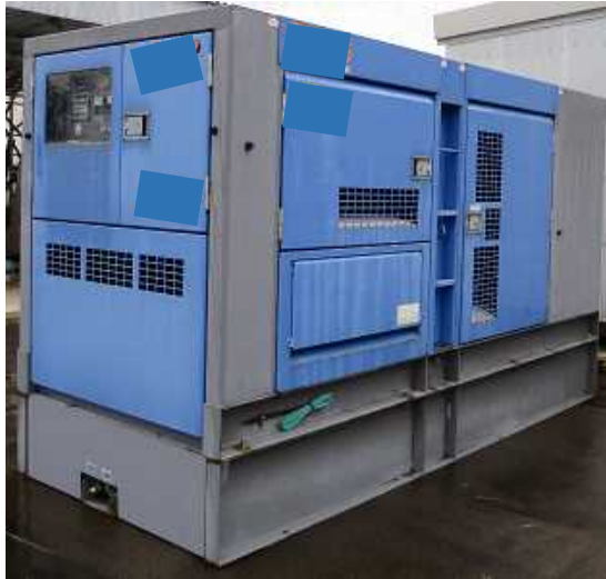
图 4-13 5号炉原子炉建屋内緊急時対策所用可搬型電源設備 外觀図
