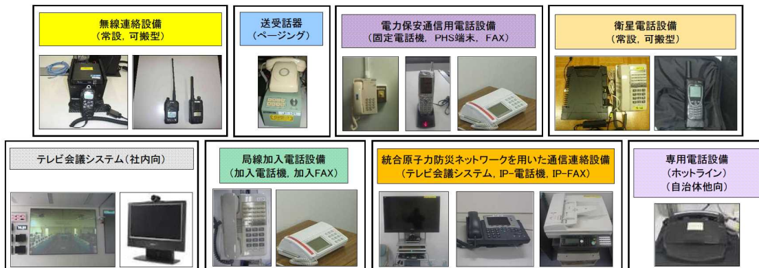
図 5.16-25 免震重要棟内緊急時対策所 2 階 通信連絡設備の概要
