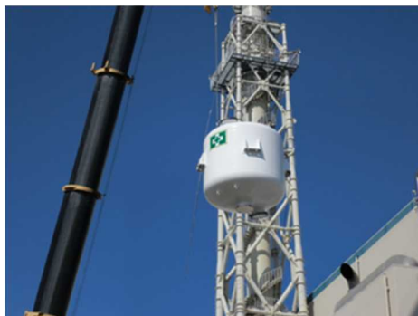
よう素フィルタの搬入・設置 (7号炉)
