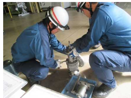
直営による安全弁の分解点検
