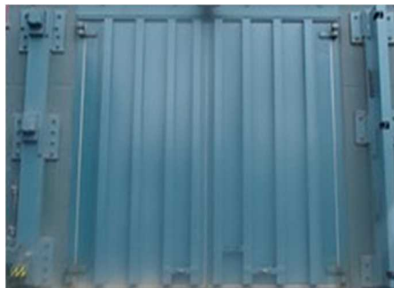
建屋扉 (従前のもの)
