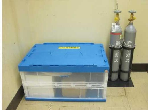
空気作動弁強制操作用の資機材配備(福島第二)
