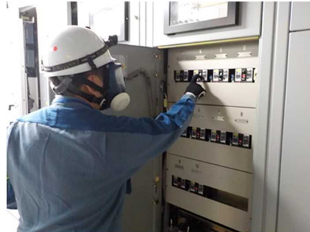
直流電源延命のための負荷カット手順に基づいた操作訓練（柏崎刈羽）
