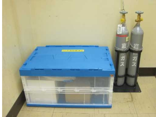
空気作動弁強制操作用の資機材配備(福島第二) (圧縮空気ポンプ, 接続用ホース, 接続部品等)
