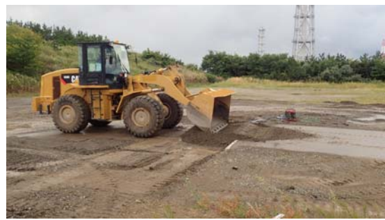
段差復旧状況②
