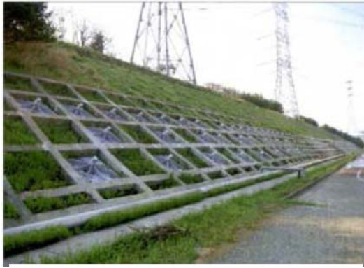
超高圧開閉所東側法面
