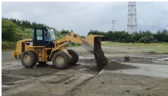
段差復旧状況①
