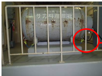
雑固体廃棄物焼却設備プロパン庫
