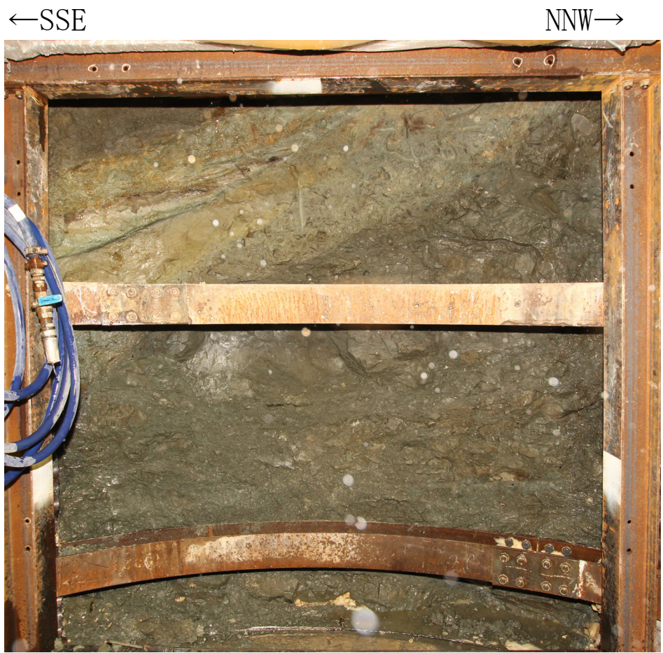
南西窓部写真
