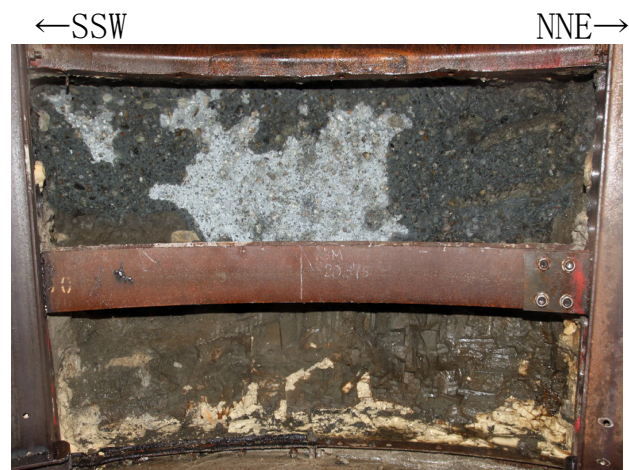
南西窓部 (全景)
