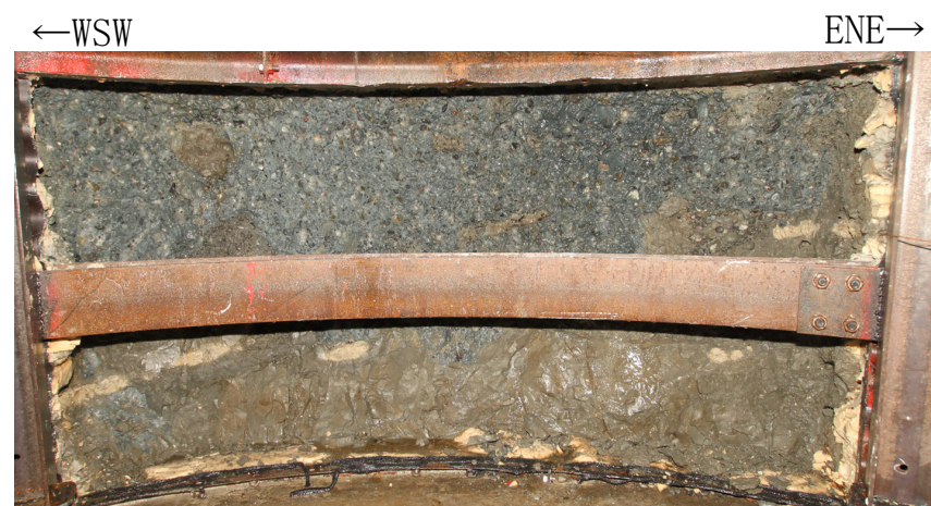
北西窓部 (全景)
