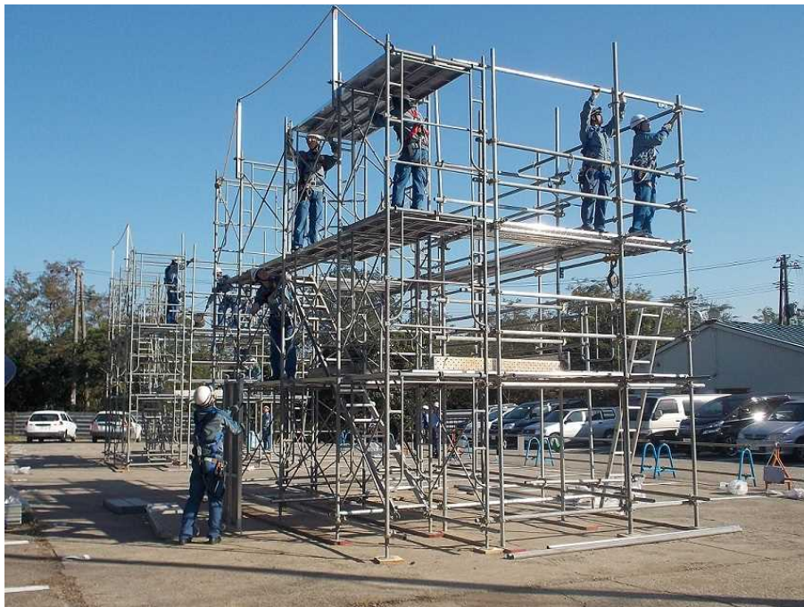
図8 非常用ガス処理系 足場組立の例
