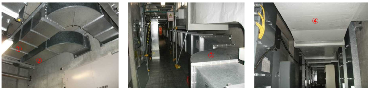
図20 バウンダリ外ダクト敷設状況
