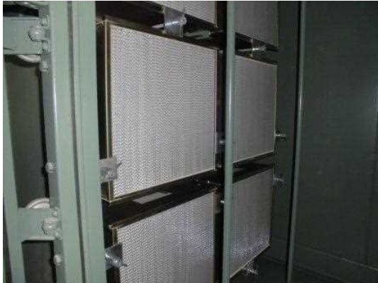
(高性能フィルタの取付け状態)
