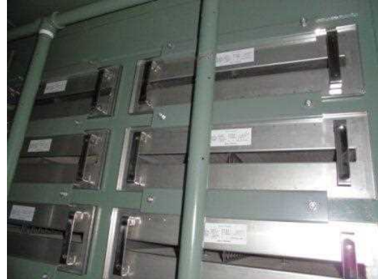
(活性炭フィルタの取付け状態)
