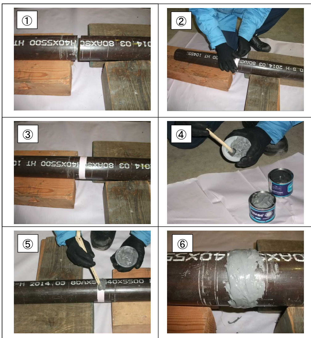
図6 ベロメタル補修の例示
