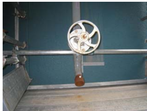
専用注水配管送水口
