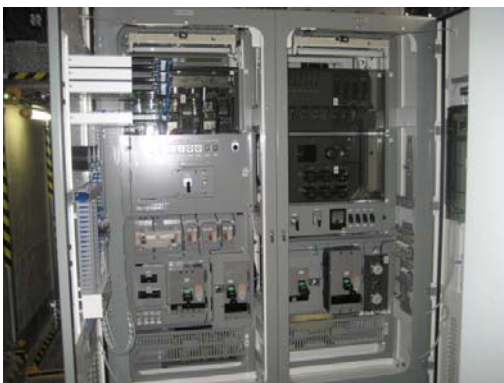
同時投入防止用切替盤
