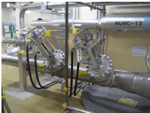
C S P吸込ライン切替対象弁
