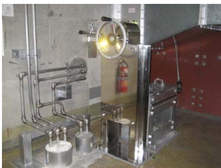
電動駆動弁 エクステンション
