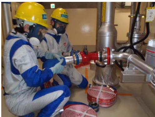
外部送水ライン接続口へホース接続（イメージ）
