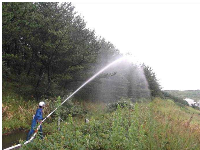
写真3 散水エリアAにおける散水状況
