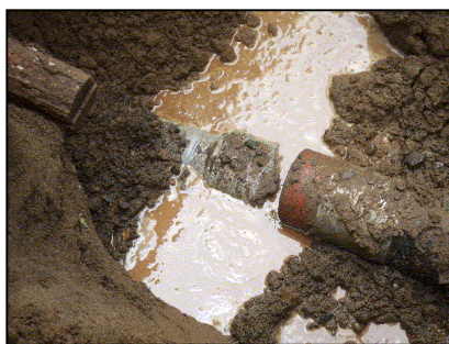
埋設消火配管の損傷
