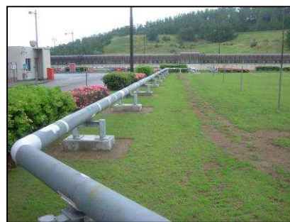
消火配管の地上化
