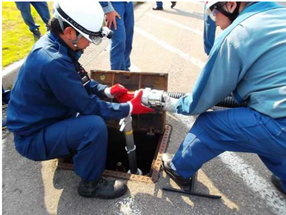
写真4 消火栓接続
