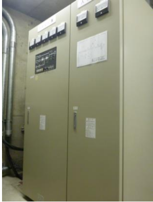
(無停電電源装置の写真)
