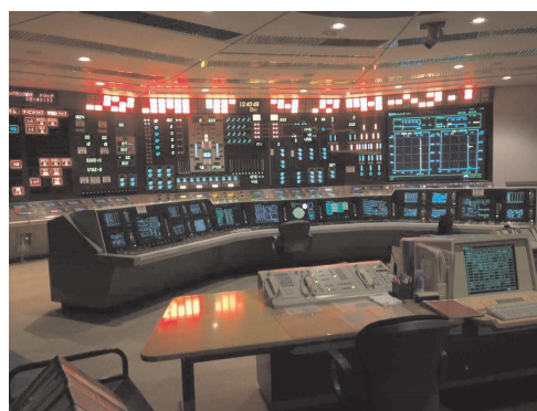
(直流非常灯点灯状態)
