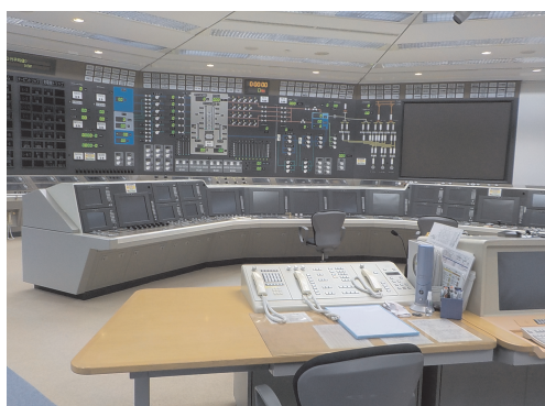
(通常点灯状態)
