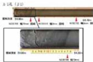
ボーリングコア写真
