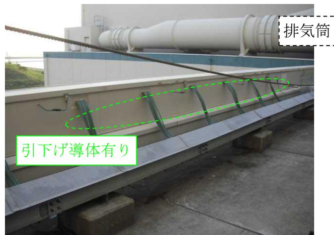
図 3-3 排気筒引下げ導体有り (7号炉)
