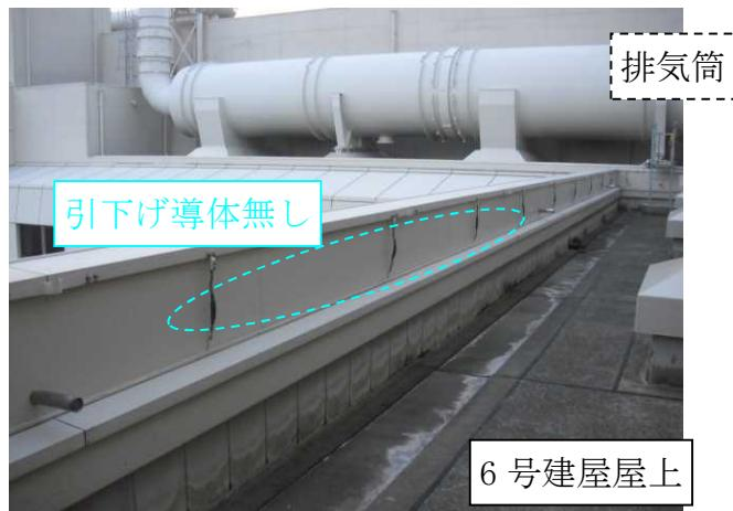
図 3-2 排気筒引下げ導体無し (6号炉)
