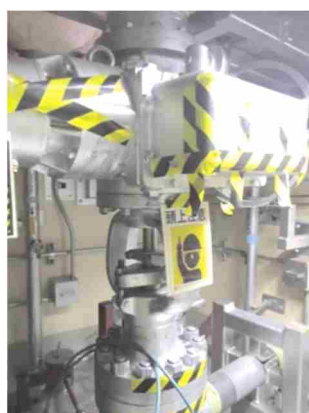
電動弁及び可とう電線管
