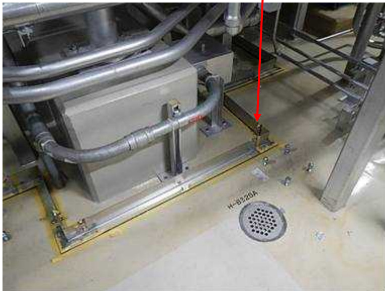
図 1 : 堰の設置状況
