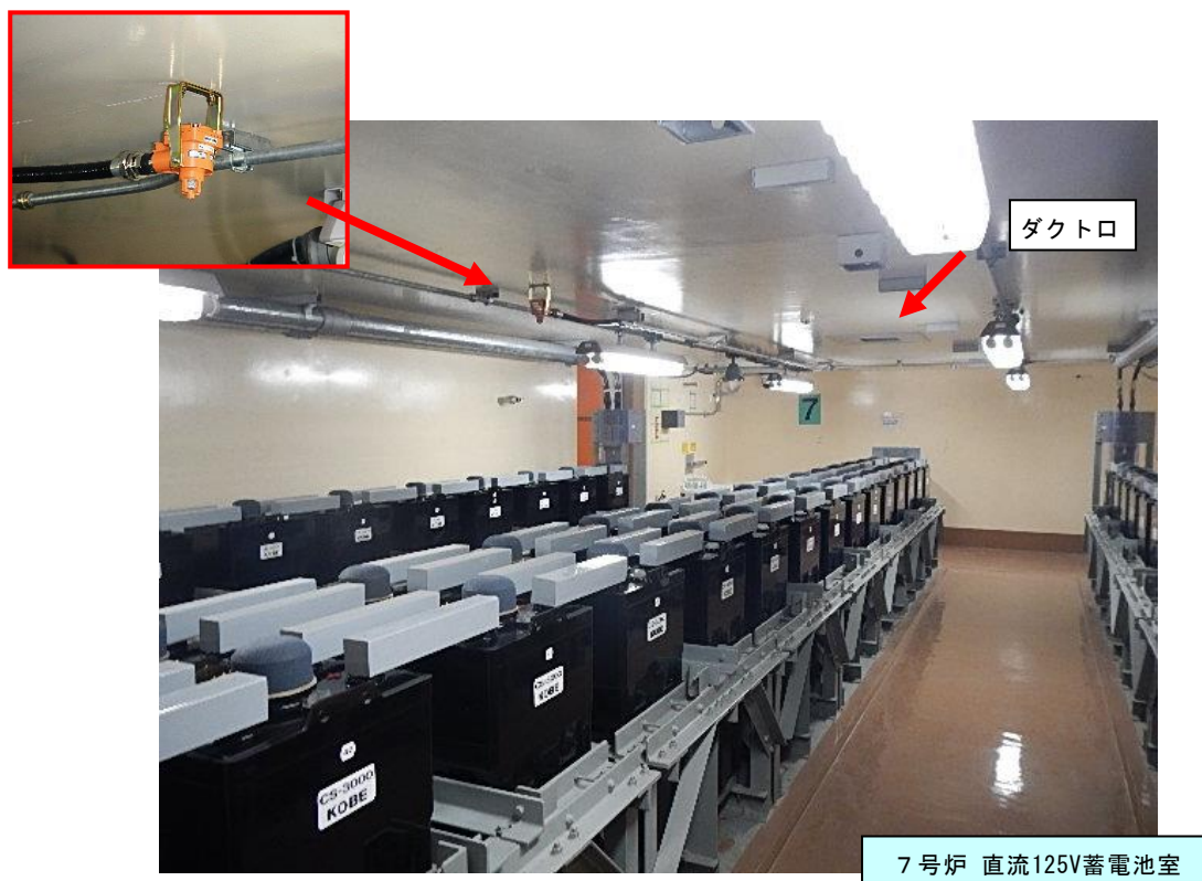
図 1-6 : 蓄電池室内の水素検出器設置状況
