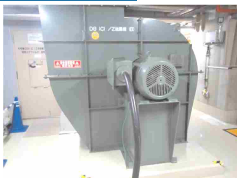
電動機及び可とう電線管
