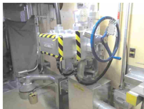
電動弁及び可とう電線管
