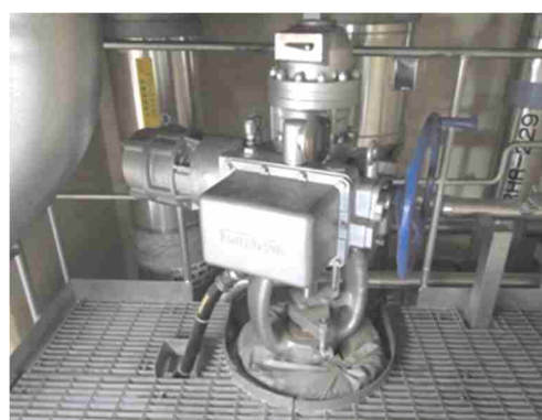
電動弁及び可とう電線管
