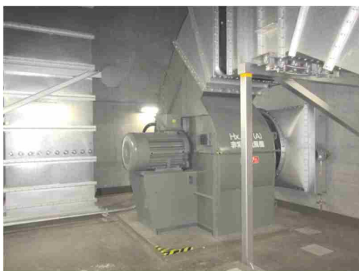
送風機，電動機及び可とう電線管
