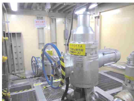
電動弁及び可とう電線管
