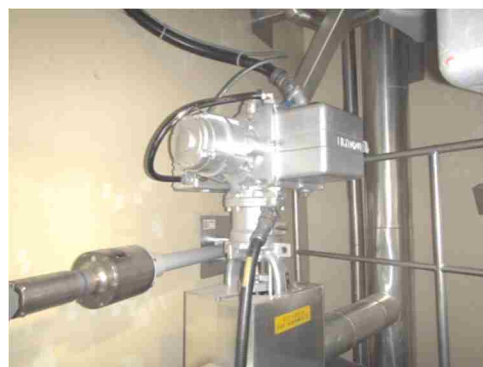
電動弁及び可とう電線管
