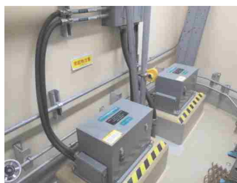
地震観測装置及び可とう電線管
