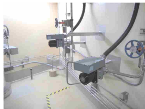
電磁弁及び可とう電線管
