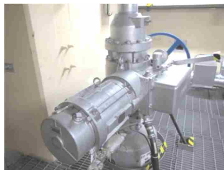
電動弁及び可とう電線管
