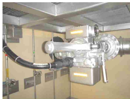
電動弁及び可とう電線管
