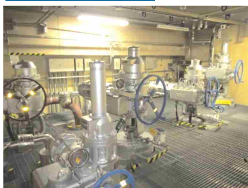
電動弁及び可とう電線管
