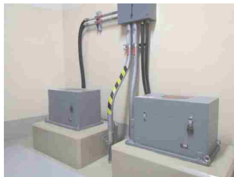
地震観測装置及び可とう電線管
