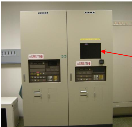
〈火災受信機盤・防災盤〉
