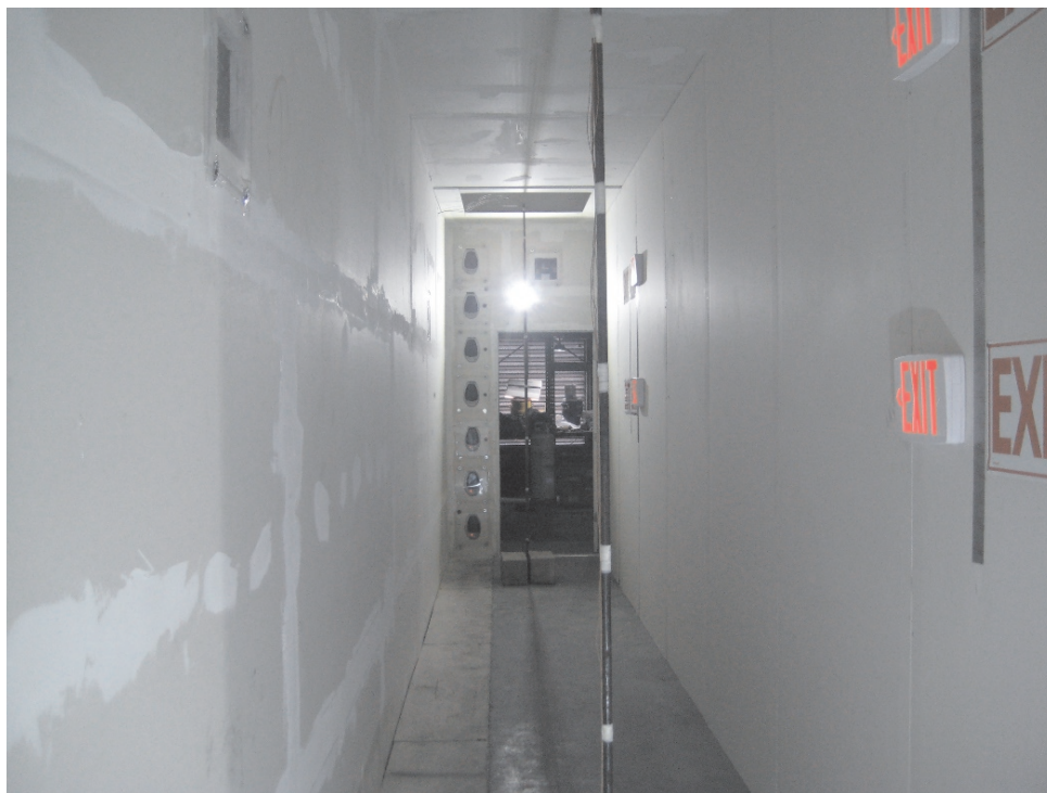
図 3.4-2 試験設備の内部，ハッチ側通路部（着火前）
