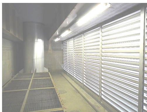
非常用ディーゼル発電機 非常用排気ルーバ室
