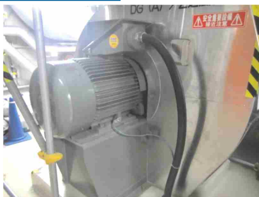
電動機及び可とう電線管
