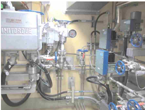
電動弁，電磁弁及び可とう電線管
