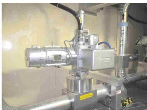
電動弁及び可とう電線管
