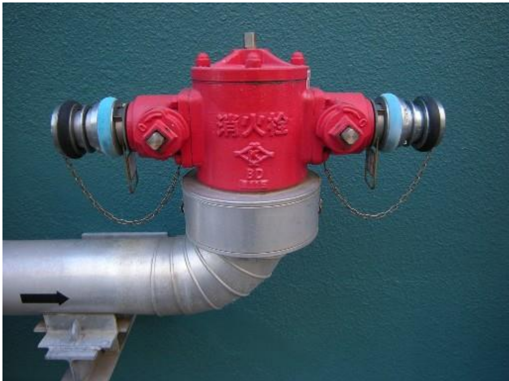
図 1-29 : 不凍式消火栓の設置状況
