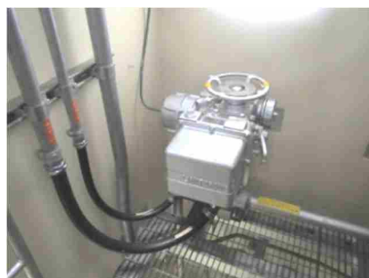
電動弁及び可とう電線管
