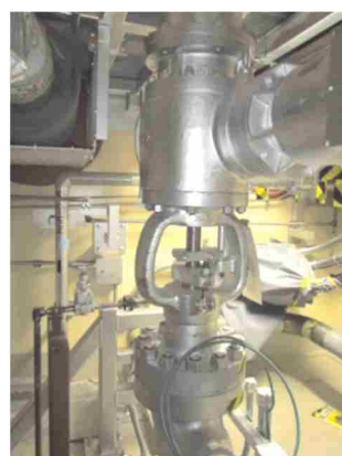
電動弁及び可とう電線管
