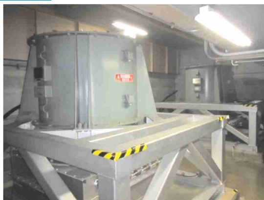
非常用送風機
