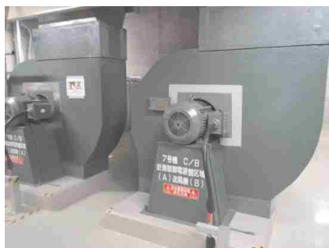
送風機，電動機及び可とう電線管
