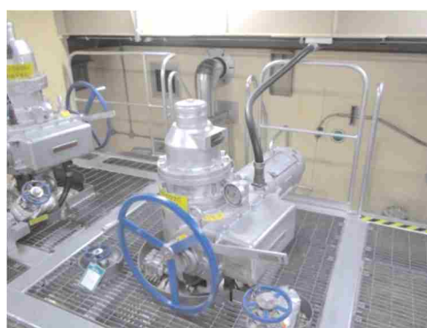
電動弁及び可とう電線管
