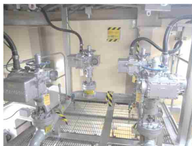
電動弁及び可とう電線管
