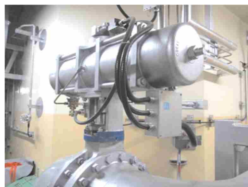
空気作動弁及び可とう電線管
