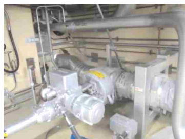
電動弁及び可とう電線管
