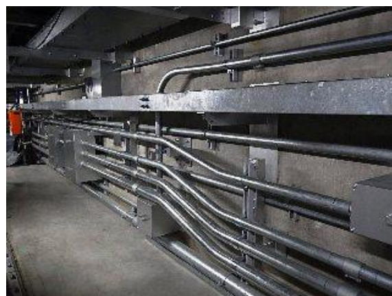
ケーブルトレイ、電線管の例
