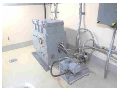
ダストサンプラ 及び可とう電線管
