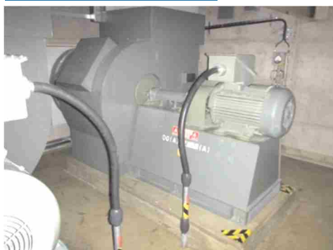
送風機，電動機及び可とう電線管
