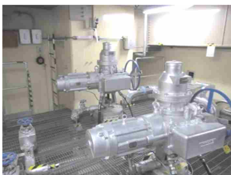
電動弁及び可とう電線管
