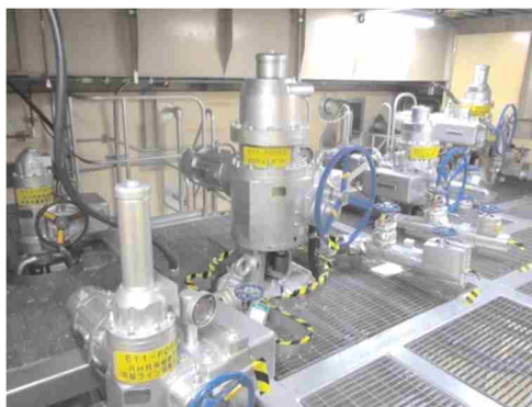
電動弁及び可とう電線管
