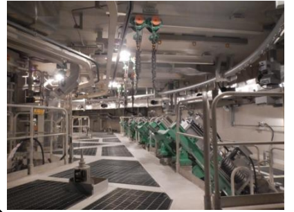
MSIV内側隔離弁 (潤滑油)
