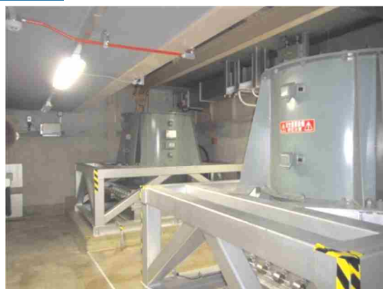
非常用送風機
