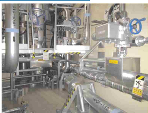
電動弁及び可とう電線管
