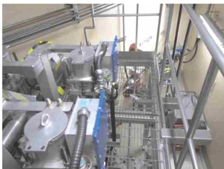
空気作動弁及び可とう電線管
