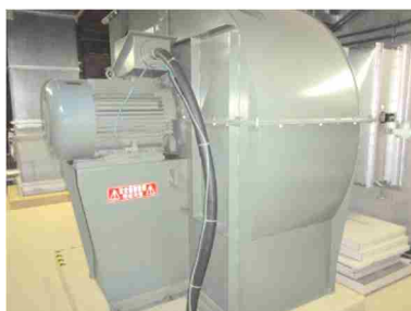
電動機及び可とう電線管
