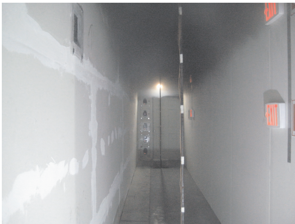
図 3.4-3 試験設備の内部，ハッチ側通路部（着火後）
