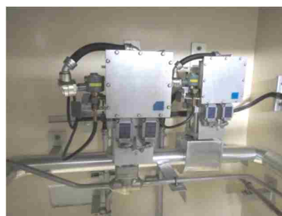
空気作動弁及び可とう電線管
