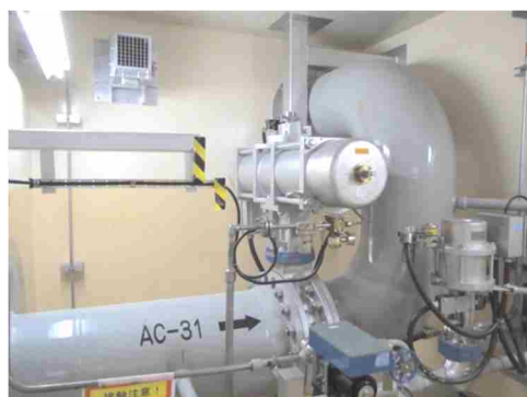
空気作動弁及び可とう電線管
