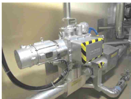
電動弁及び可とう電線管
