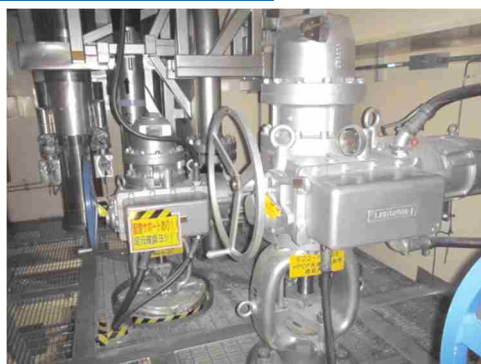
電動弁及び可とう電線管
