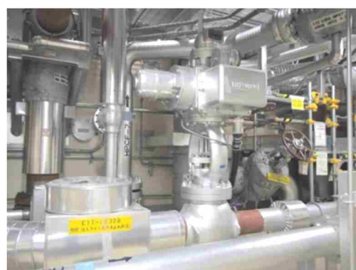
電動弁及び可とう電線管
