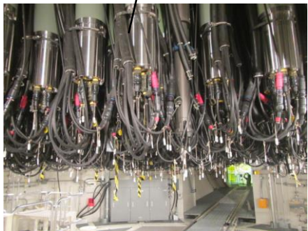
格納容器下部ケーブル
