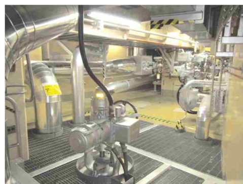
電動弁及び可とう電線管
