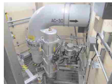
空気作動弁及び可とう電線管
