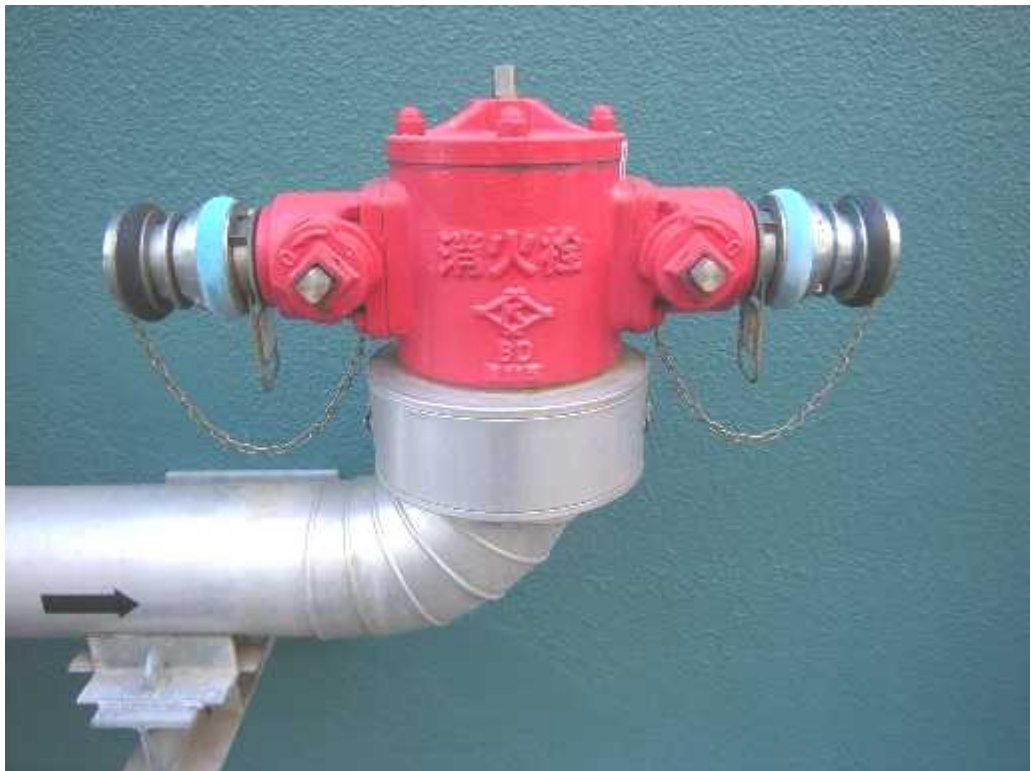
図 10-32 : 不凍式消火栓の設置状況
