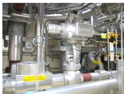
電動弁及び可とう電線管
