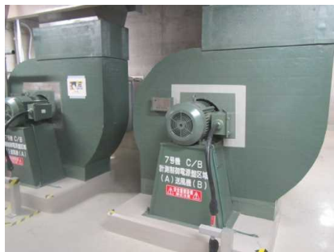
送風機，電動機及び可とう電線管
