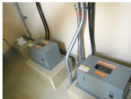
地震観測装置及び可とう電線管
