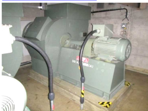
送風機，電動機及び可とう電線管
