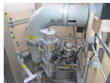
空気作動弁及び可とう電線管
