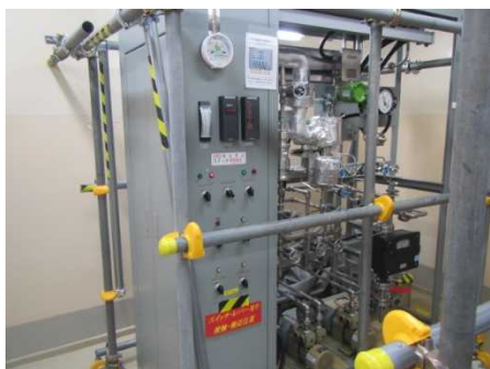
計装ラック及びサンプルポンプ
