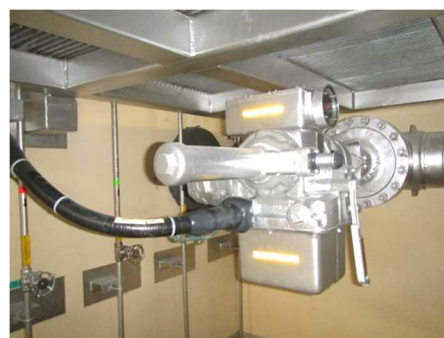
電動弁及び可とう電線管
