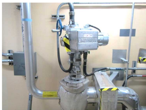
電動弁及び可とう電線管
