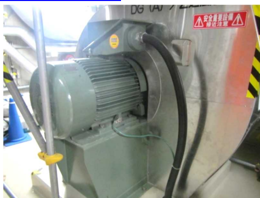
電動機及び可とう電線管
