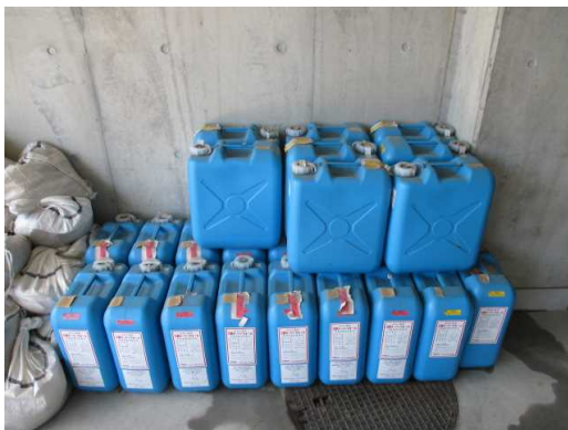
図4 泡消火薬剤ポリタンク 500 リットル
