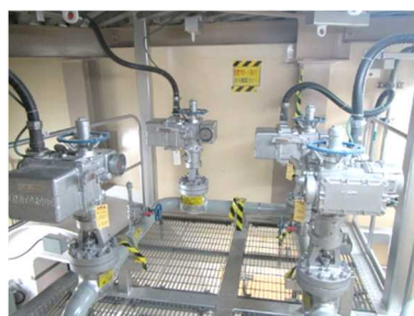
電動弁及び可とう電線管
