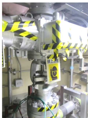
電動弁及び可とう電線管
