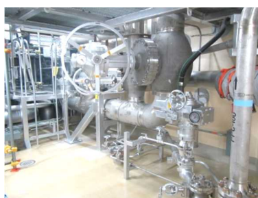
電動弁及び可とう電線管
