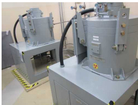
放射線モニタ及び可とう電線管
