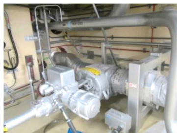
電動弁及び可とう電線管
