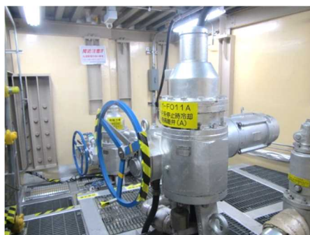
電動弁及び可とう電線管
