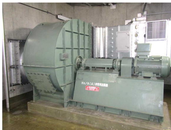
送風機及び電動機
