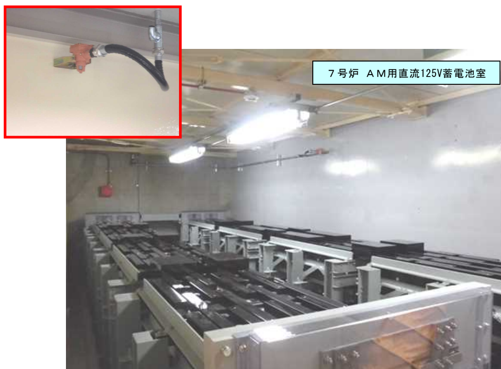
図 10-6 : 蓄電池室内の水素検出器設置状況
