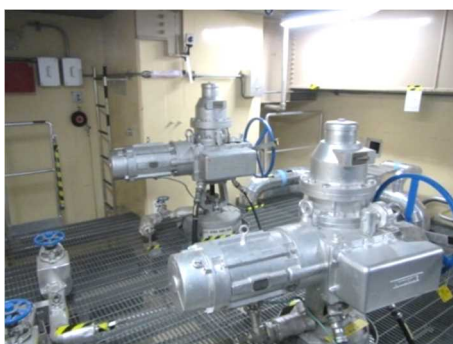
電動弁及び可とう電線管
