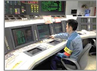
①運転状況監視
