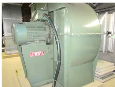
電動機及び可とう電線管
