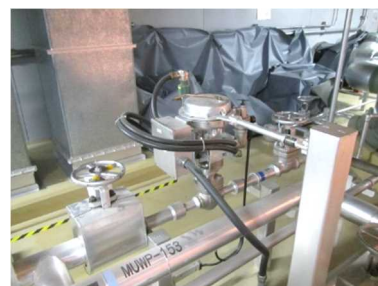
空気作動弁及び可とう電線管
