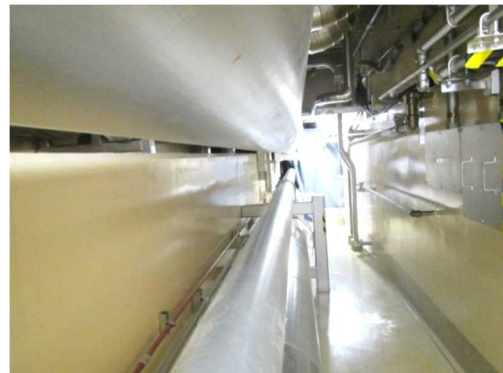
配管及び電線管
