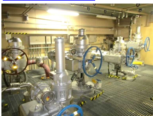
電動弁及び可とう電線管
