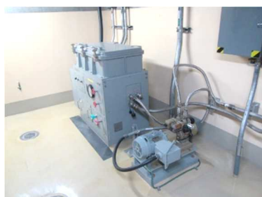
ダストサンプラ 及び可とう電線管
