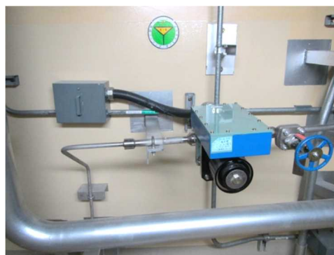
電磁弁及び可とう電線管
