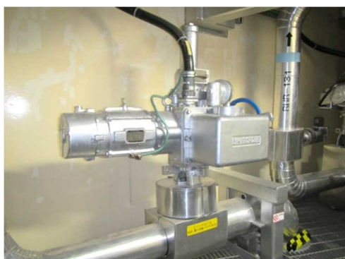
電動弁及び可とう電線管
