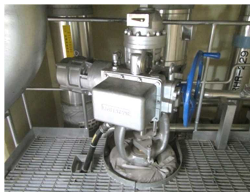
電動弁及び可とう電線管
