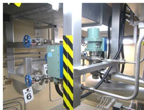
電磁弁及び可とう電線管
