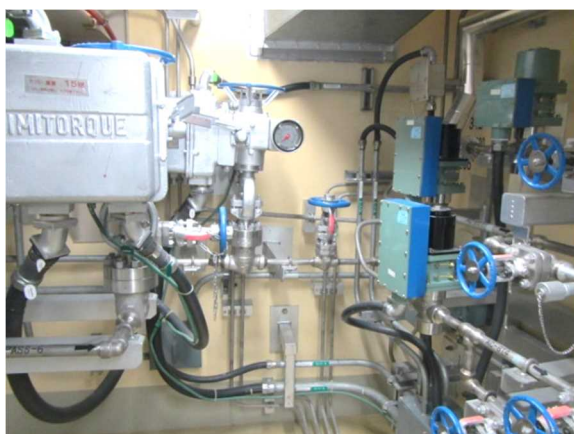
電動弁，電磁弁及び可とう電線管
