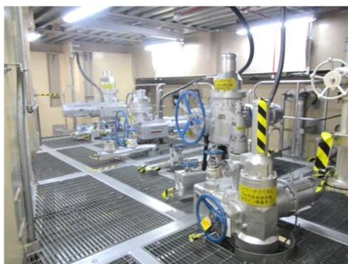
電動弁及び可とう電線管
