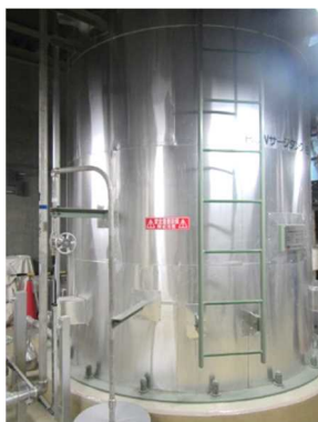
サージタンク
