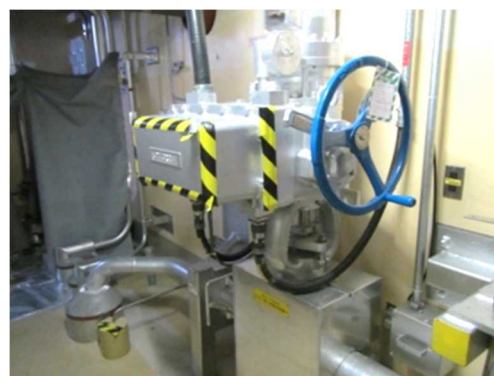
電動弁及び可とう電線管
