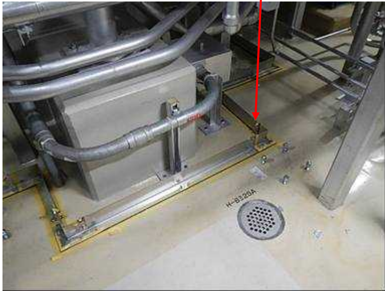
図 1 : 堰の設置状況
