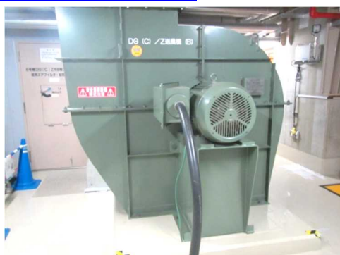
電動機及び可とう電線管
