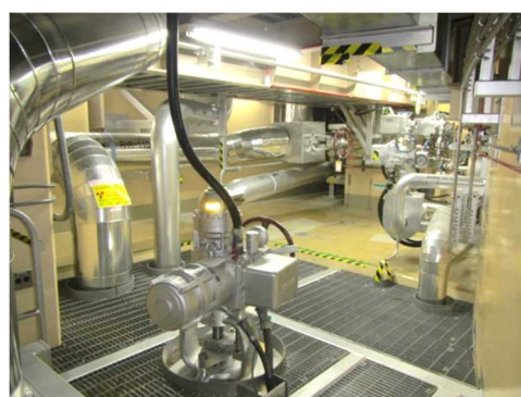
電動弁及び可とう電線管
