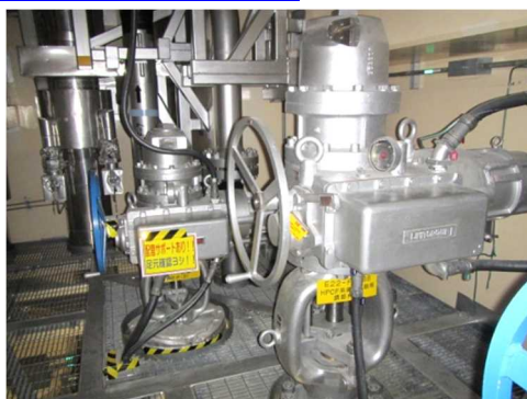
電動弁及び可とう電線管
