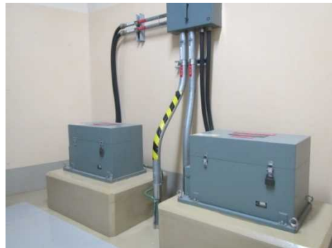
地震観測装置及び可とう電線管
