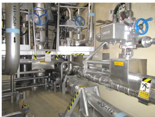
電動弁及び可とう電線管
