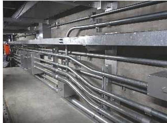
ケーブルトレイ、電線管の例
