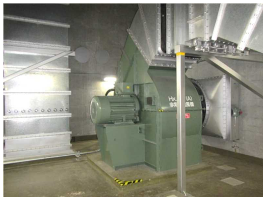
送風機，電動機及び可とう電線管
