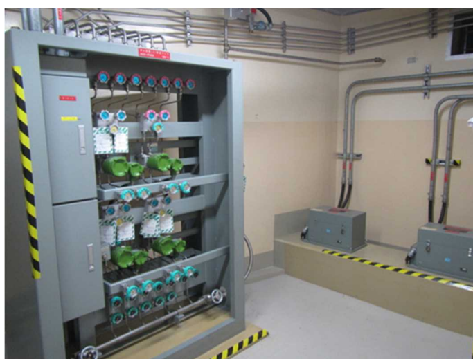
計装ラック及び地震観測装置
