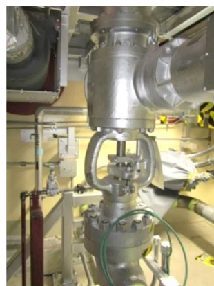
電動弁及び可とう電線管
