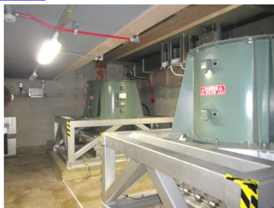
非常用送風機
