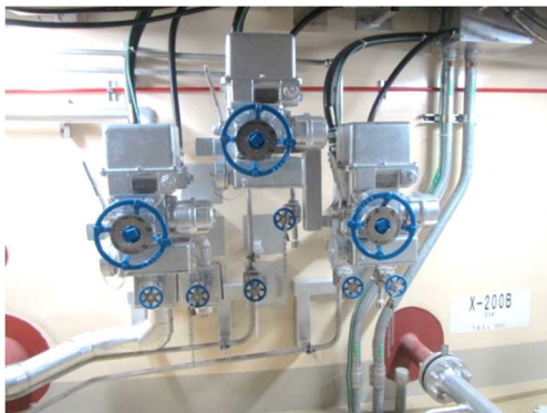
電動弁及び可とう電線管
