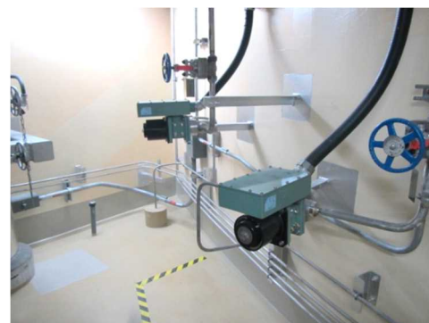
電磁弁及び可とう電線管
