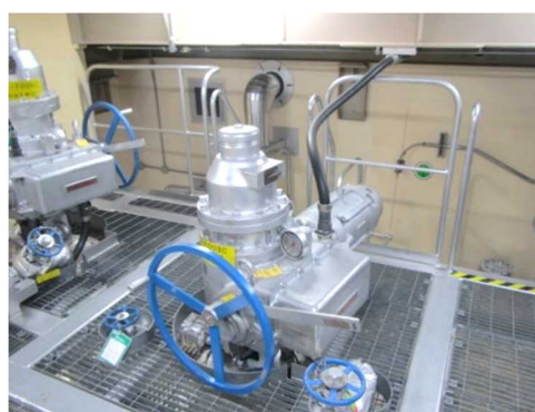
電動弁及び可とう電線管
