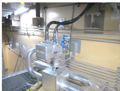
電動弁及び可とう電線管
