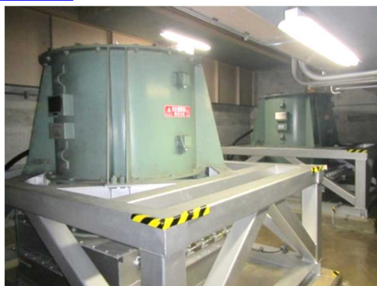
非常用送風機
