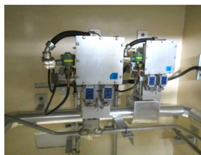
空気作動弁及び可とう電線管
