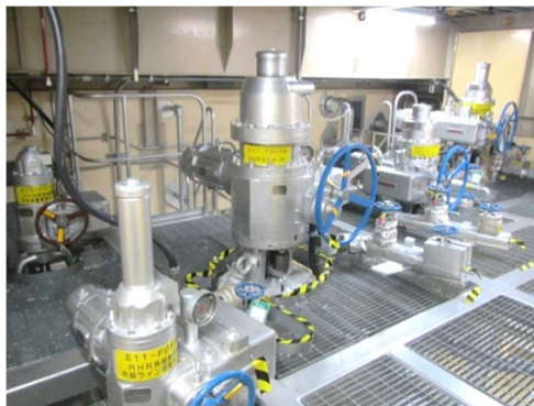
電動弁及び可とう電線管
