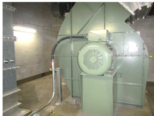
送風機，電動機及び可とう電線管
