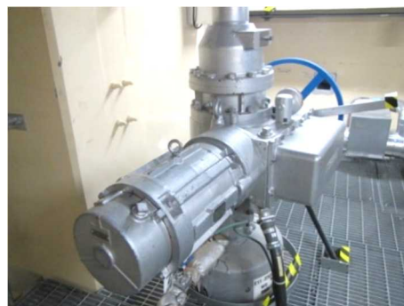
電動弁及び可とう電線管
