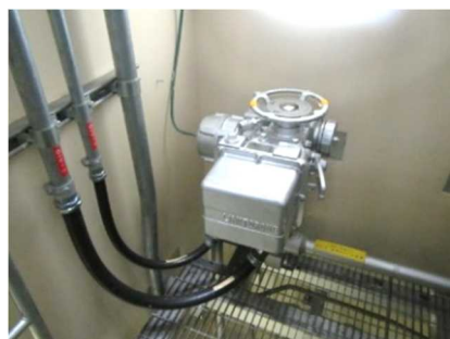
電動弁及び可とう電線管
