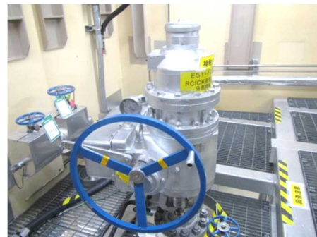
電動弁及び可とう電線管
