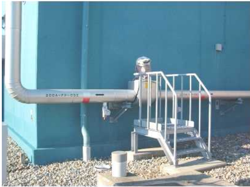
図 10-31 : 屋外消火配管への保温材設置状況
