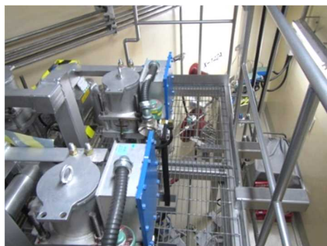
空気作動弁及び可とう電線管
