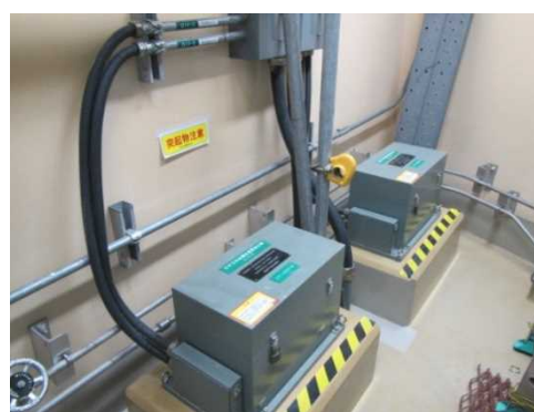
地震観測装置及び可とう電線管
