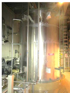
サージタンク
