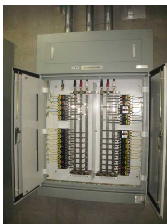
配線用遮断器の例 (ブレーカー)
