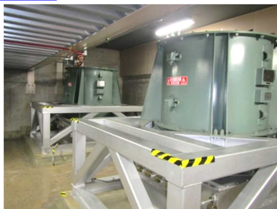
非常用送風機
