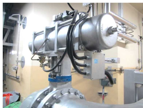
空気作動弁及び可とう電線管
