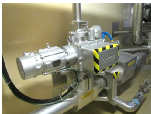
電動弁及び可とう電線管
