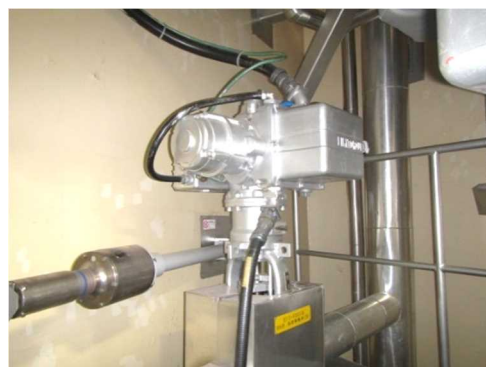
電動弁及び可とう電線管
