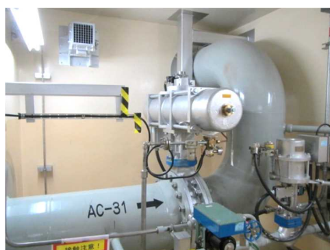
空気作動弁及び可とう電線管
