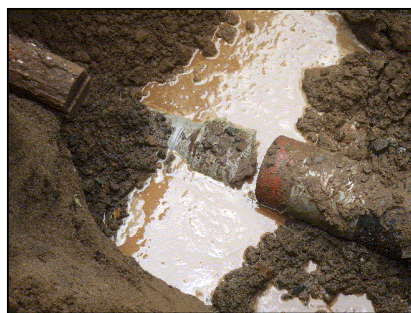
埋設消火配管の損傷
