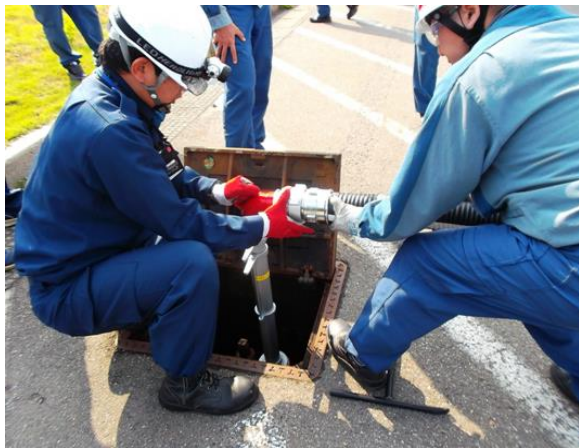
写真4 消火栓接続
