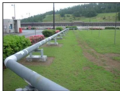
消火配管の地上化
