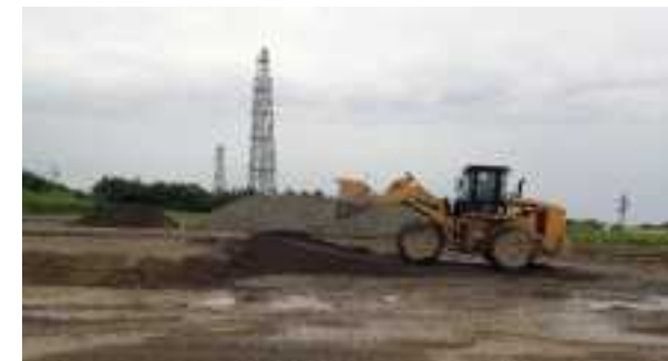
段差復旧状況
