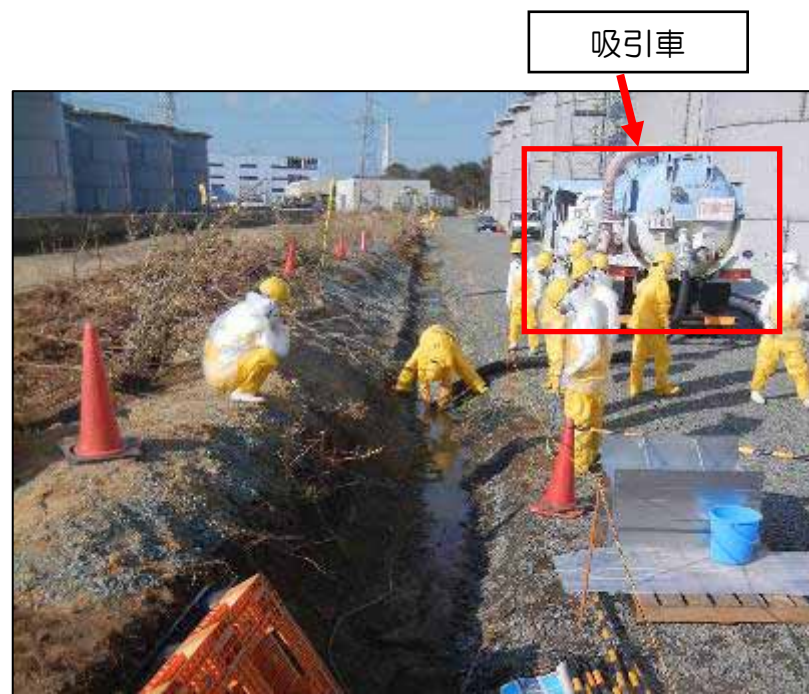
漏えい物回収作業の様子
