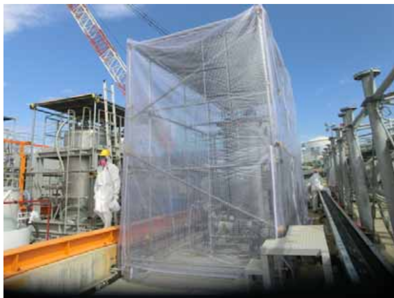
ビニールシート養生の一例
