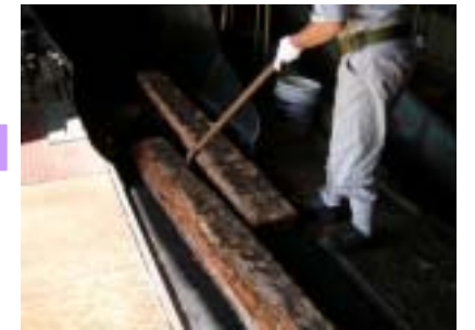
腐食部分を除去した木道
