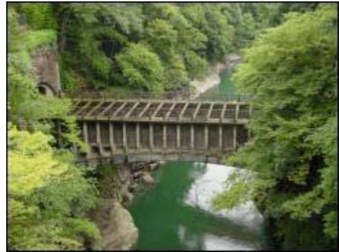
第1号水路橋 すいりょうきょう
