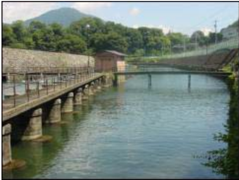
取水口沈砂池 ちんさち
