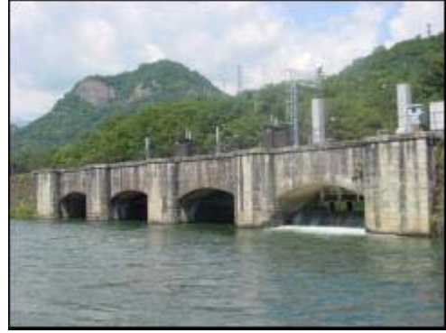
取水口制水門 せいすいもん
