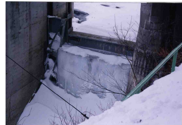
洪水吐きゲート凍結写真(平成7年度):正面より撮影
