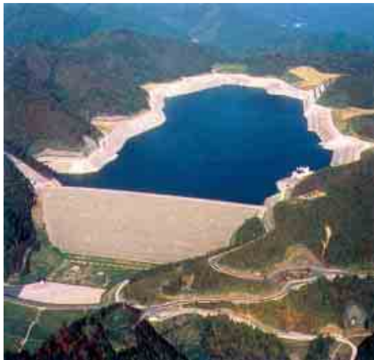
写真 - 1 栗山ダム全景
