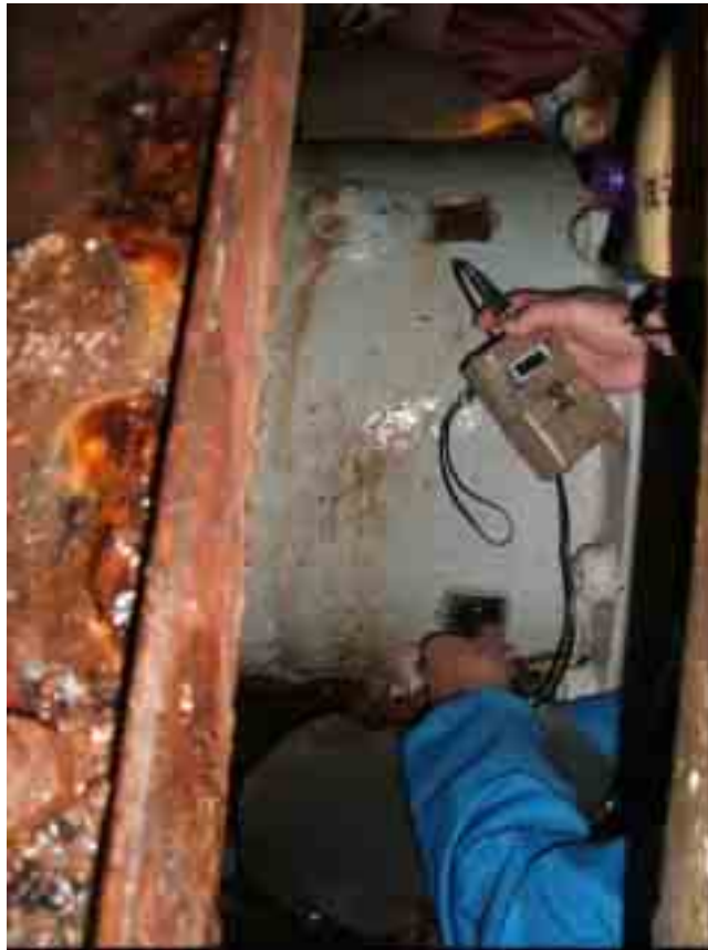
写真－1：放流管板厚測定実施状況
