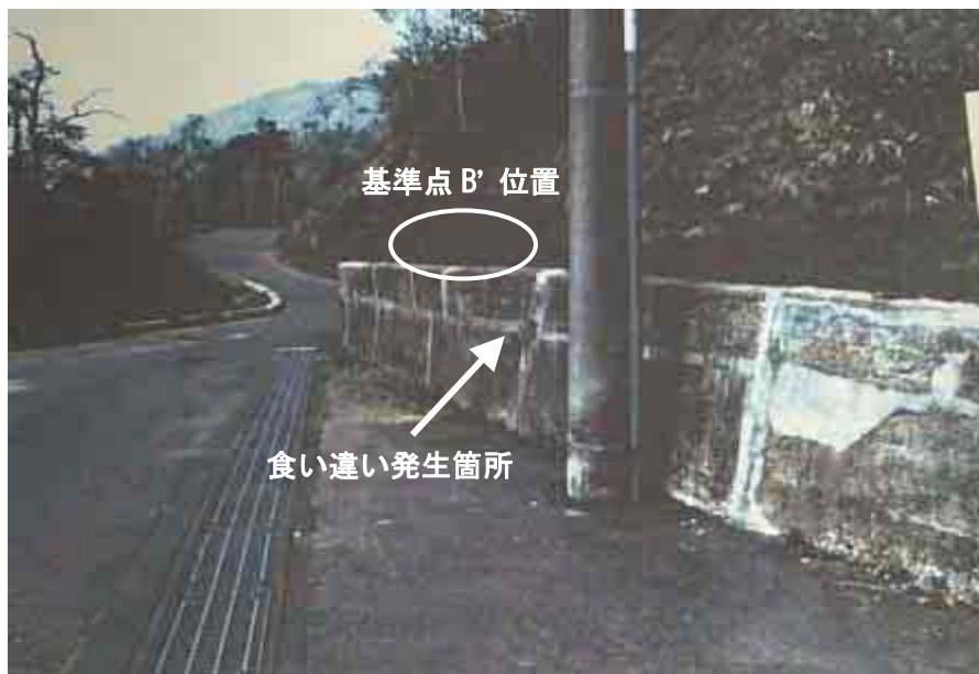
写真－7 中段右岸道路擁壁（基準点 B' 近傍） 食い違い状況：遠景（平成 2 年）
