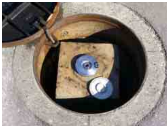
写真－3 No. 10 測定点状況（現在・近景）
