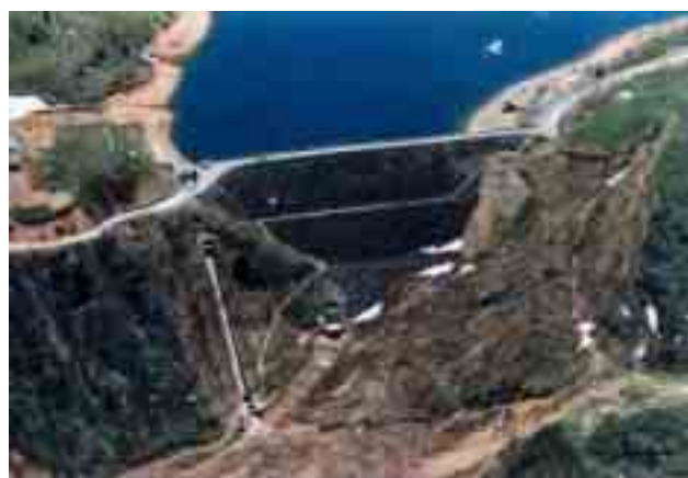
写真-1 野反ダム全景
