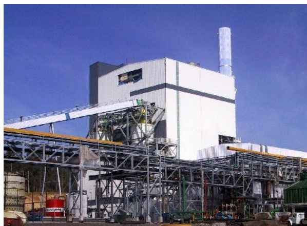
ヌエバルデアバイオマス発電所
