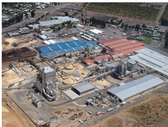
トゥルパンバイオマス発電所
