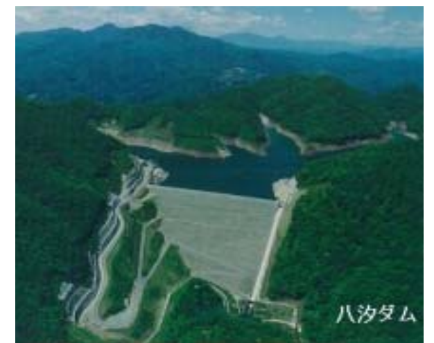
八汐ダム・調整池全景
