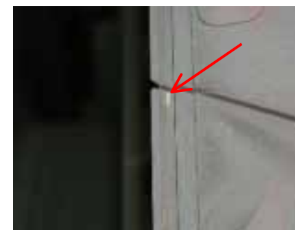
第8段発電機側シュラウドリング
