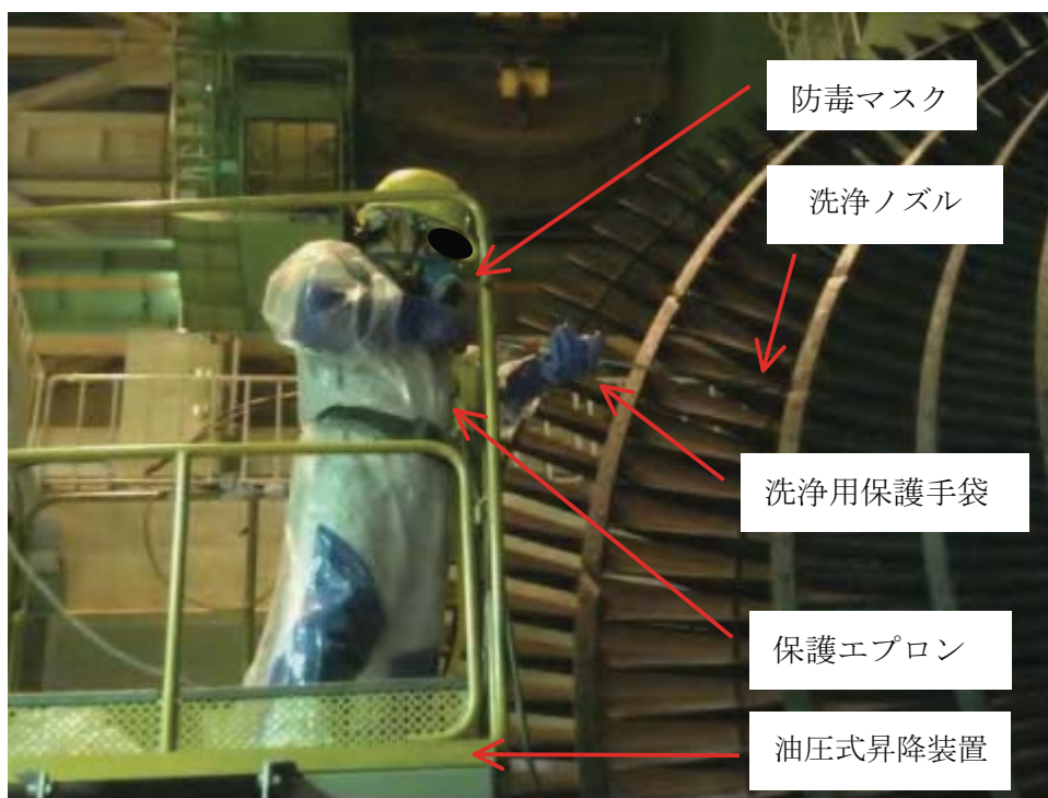
油圧式昇降装置上での洗浄作業風景
