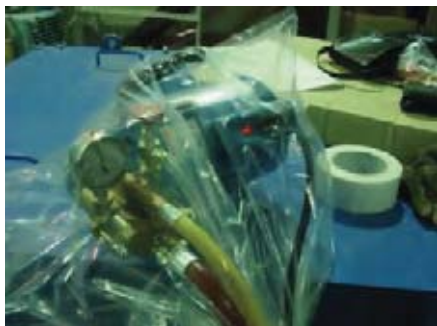
ビニールによる養生状態
