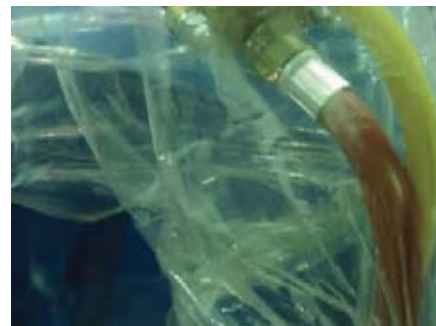
15分運転後のビニール養生内部状態
