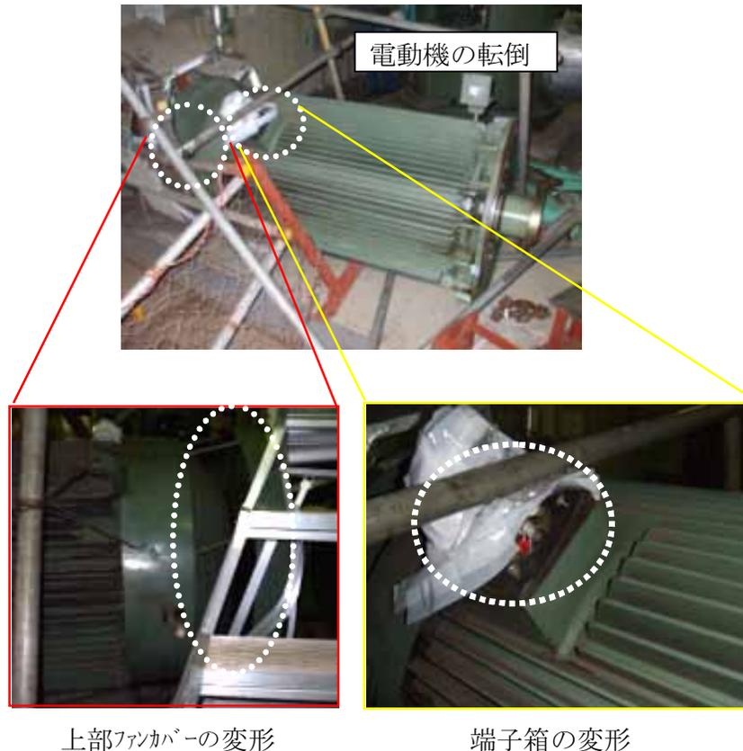
消火配管破損に伴う浸水事象の概要について
