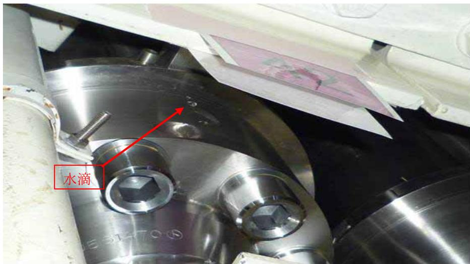
図－1 制御棒駆動機構フランジ部からの漏えい事象
