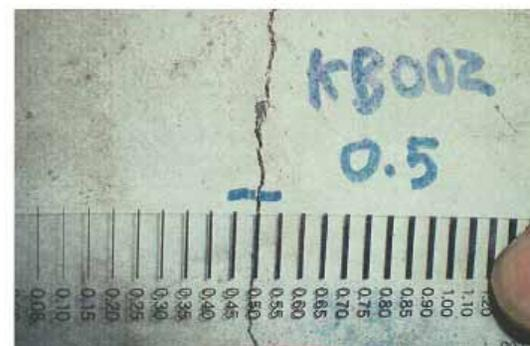
「非常用ディーゼル発電設備(空気圧縮設備(空気だめ))(A)(H)」に想定される破壊パターンと確認されたひび割れ状況
